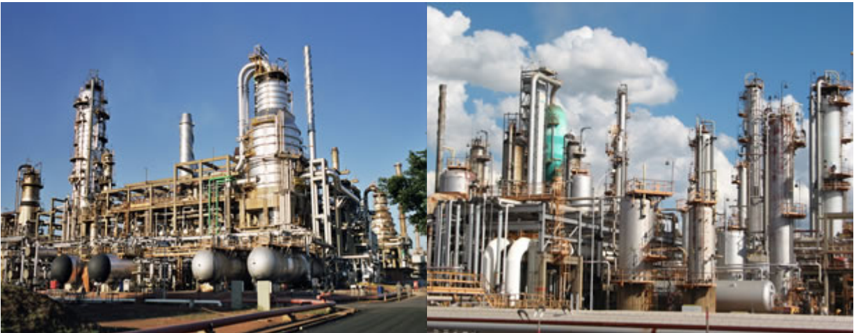
Figura 3.11 – Unidade de Destilação Atmosférica e a Vácuo e Unidade de Craqueamento Catalítico
