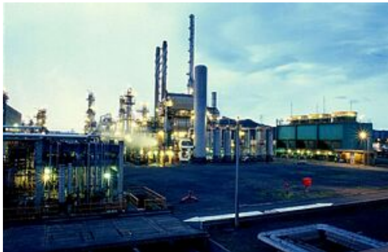
Figura 16 - Unidade de Hidrotratamento de Instáveis RPBC
