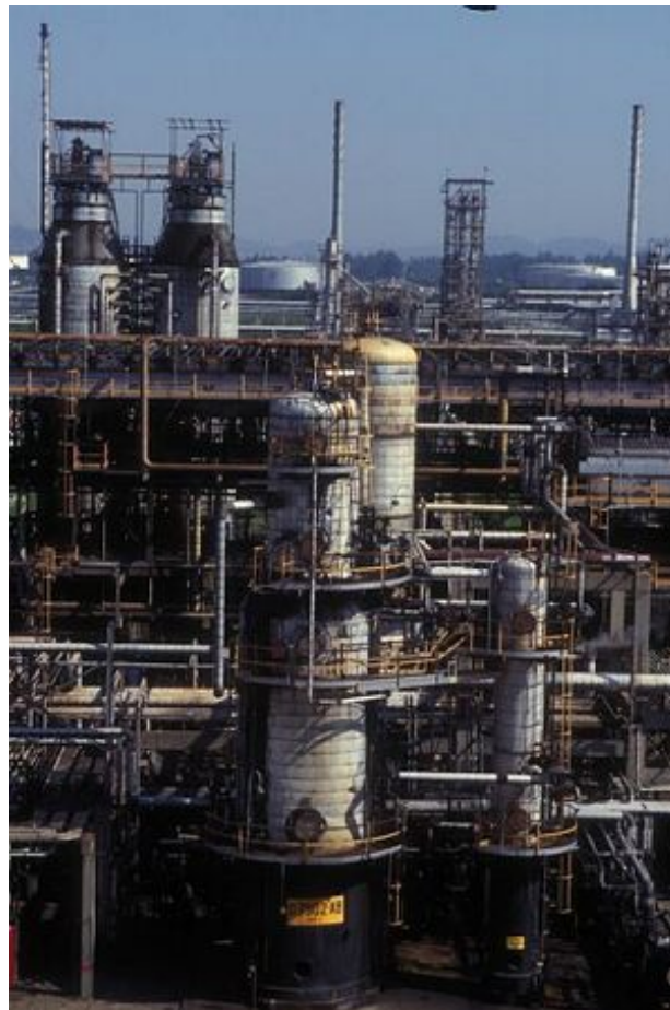
Figura 4 – Unidade de Desasfaltação a Solvente REDUC (U-1790)
