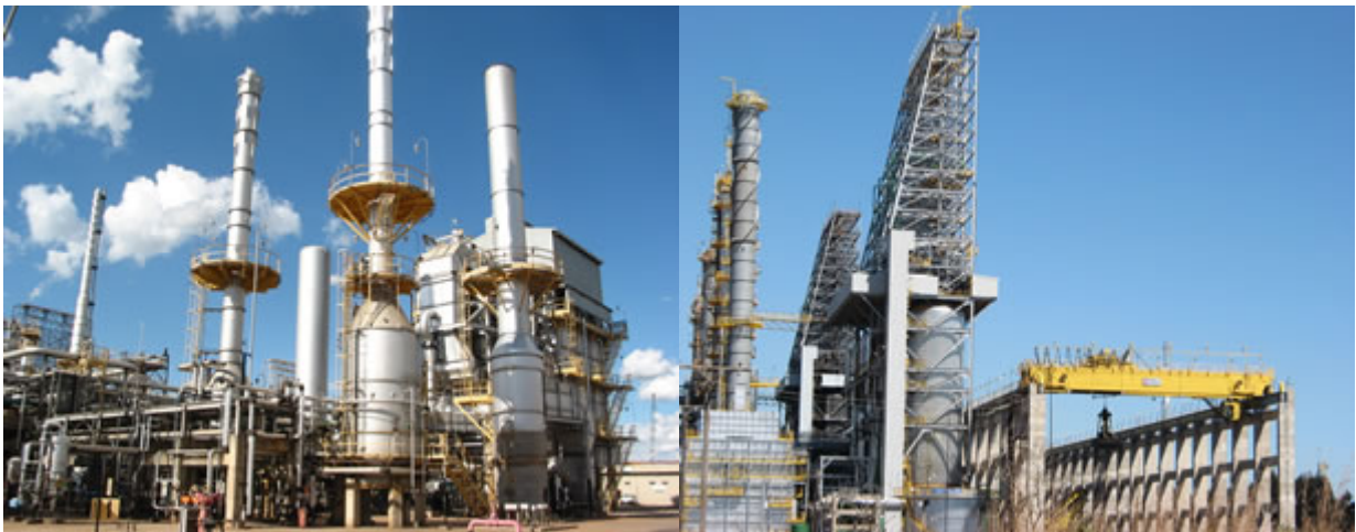
Figura 3.12 – Unidade de Hidrotratamento de Instáveis e Unidade de Coqueamento Retardado
