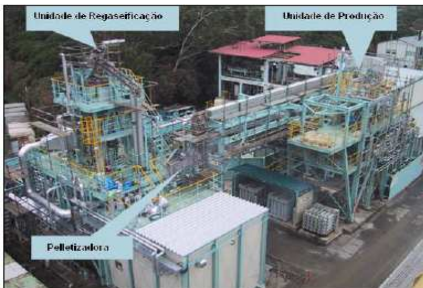
Figura 111 - Planta de produção de HGN na forma de pellets . Fonte: NGH JAPAN , 2009.
