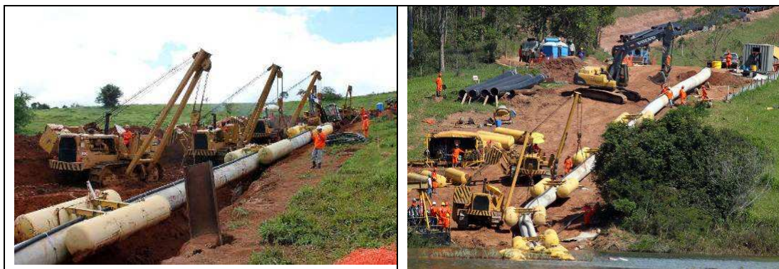
Figura 13 – Construção do gasoduto GASCAC em trecho seco.
