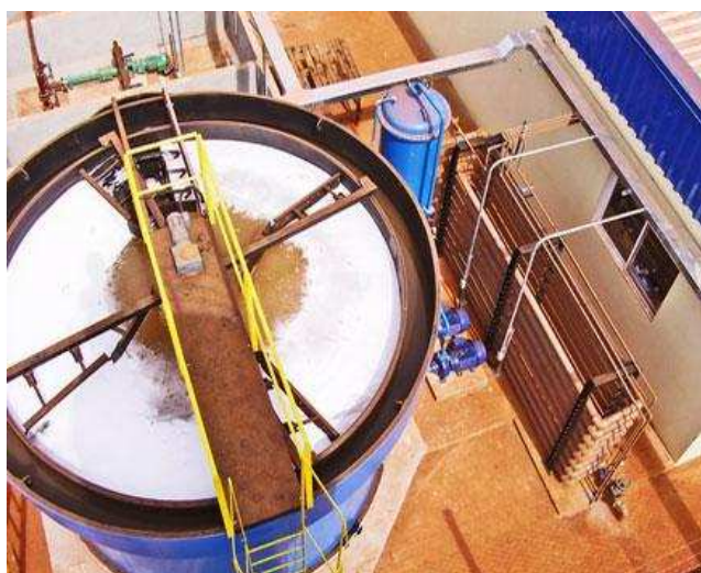
Figura 3 - Flotador a Ar Dissolvido
