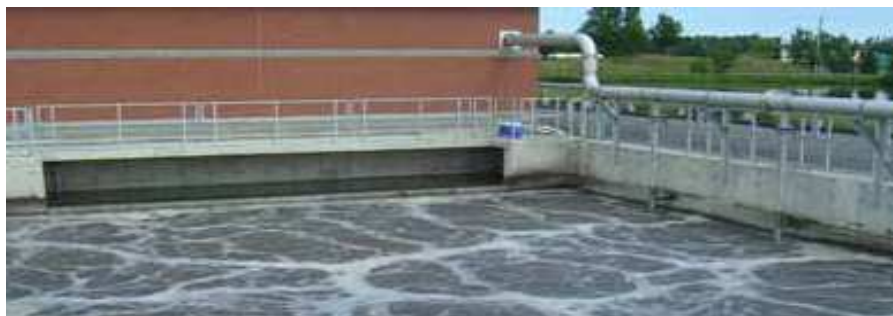
Figura 8 – Reator do tipo MBBR
