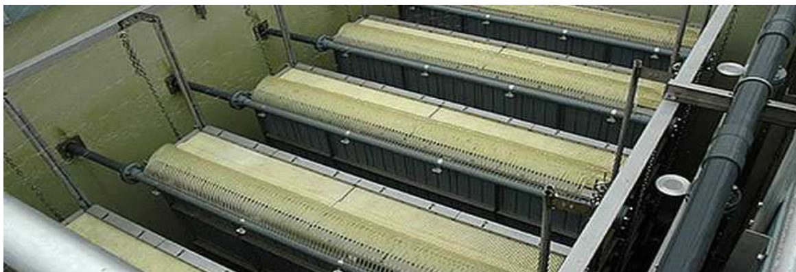
Figura 12 - Biorreator com membranas vazio
