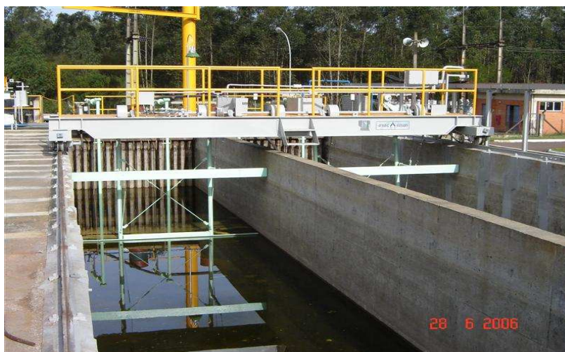
Figura 2 - Separador água-óleo do tipo API
