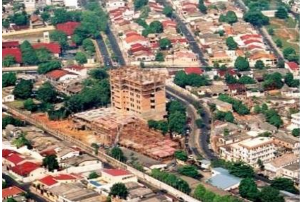
Figura 6 - Obra de ampliação da FCECON/AM
