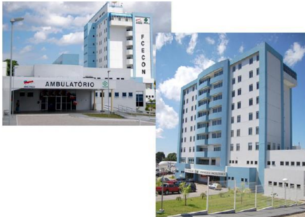
Figura 7 - Construção do novo prédio da FCECON/AM 2003/2006
