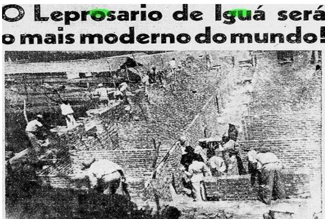
Figura 1 - A fotografia registra um grupo de operários construindo os pavilhões da Colônia de Iguá
