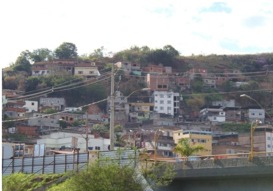
Figura 33 - Vista Parcial do Bairro do Dom Bosco. Fonte: A autora, 2012.
