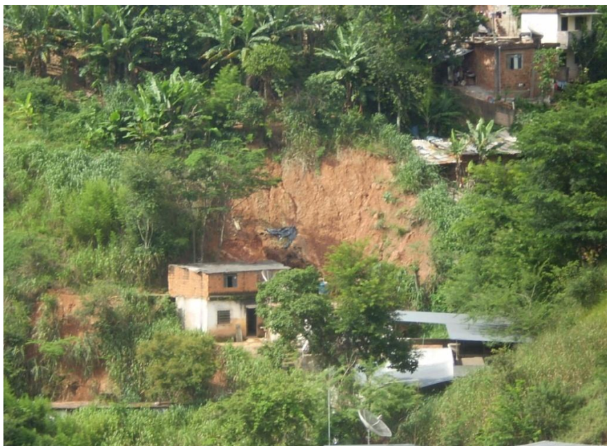
Figura 26 - Vista Parcial Alto Três Moinhos - Área degradada. Fonte: A autora, 2011.
