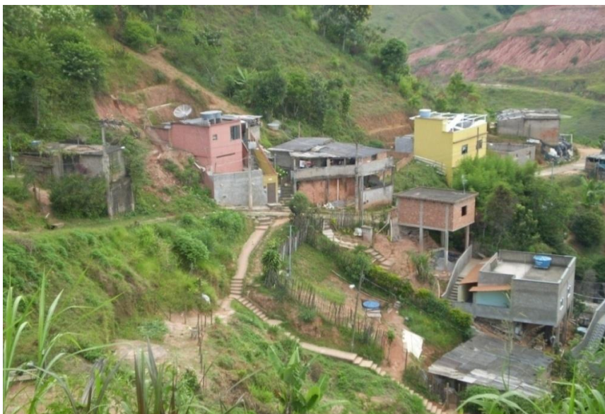
Figura 24 - Vista Parcial Alto Três Moinhos - Escadas de acesso. Fonte: A autora, 2011.
