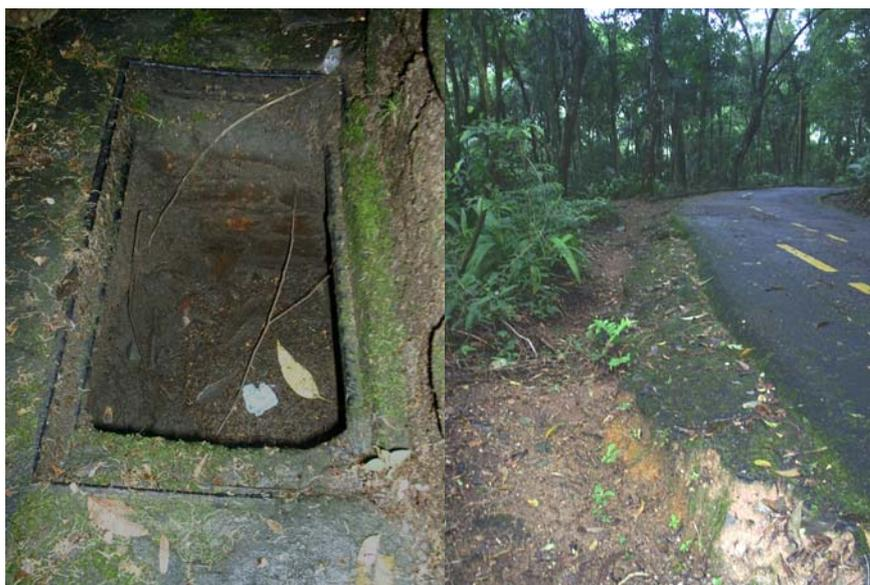
Fotos 24 e 25 - Boeiro entupido e erosão da margem da Estrada dos Picos, nas proximidades do Lago das Fadas (Fotos de Ricardo Malta, em 9 de janeiro de 2008).
