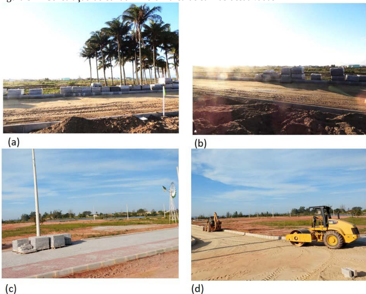
Figura 52 - Construção de condomínio em área de salinas desativadas
