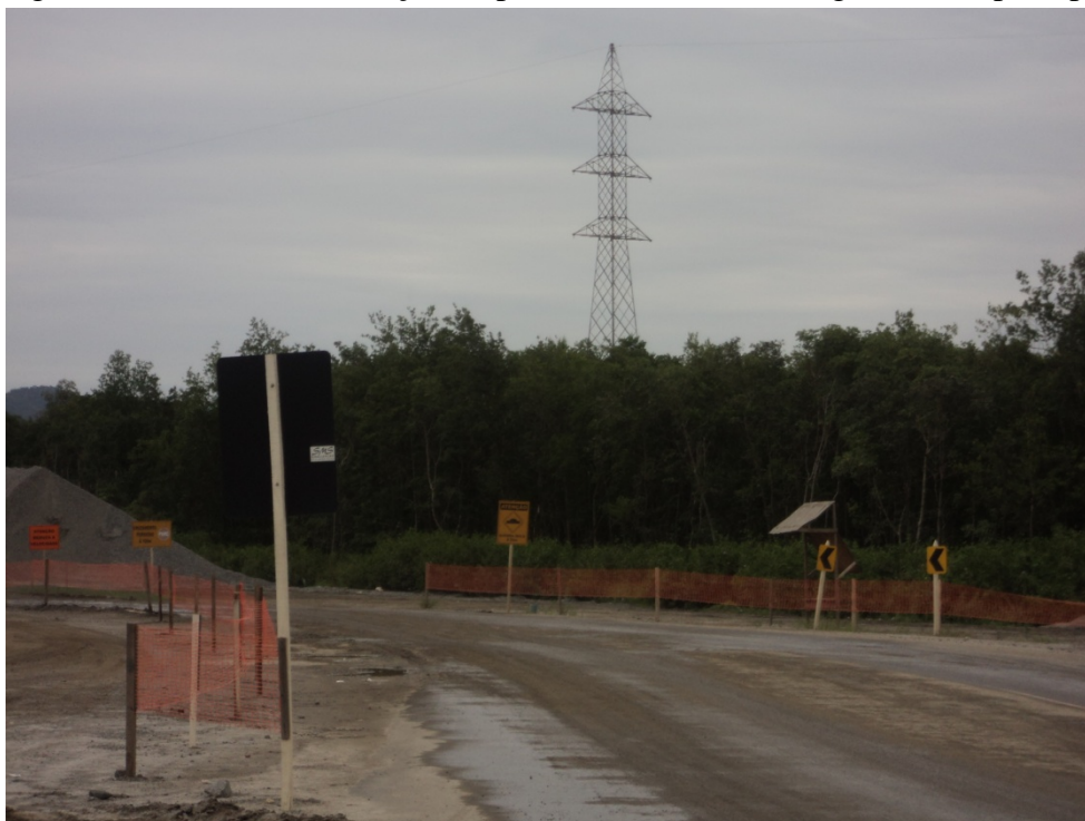
Figura 31 - Obra de construção da pera ferroviária, na antiga área ocupada pelo manguezal.
