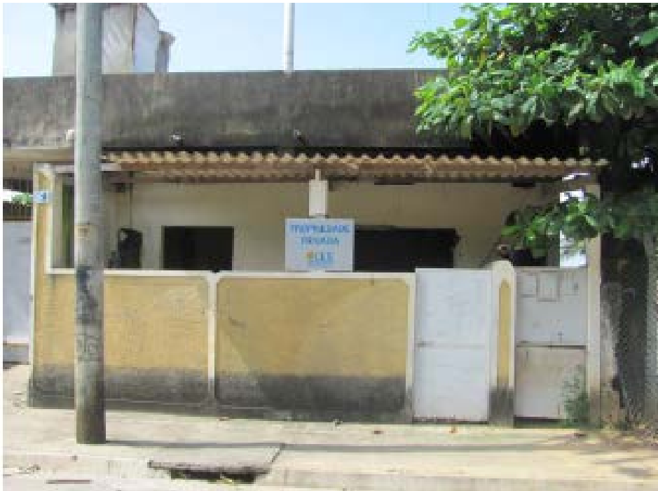
Figura 19 - Imóvel adquirido, aguardando demolição
