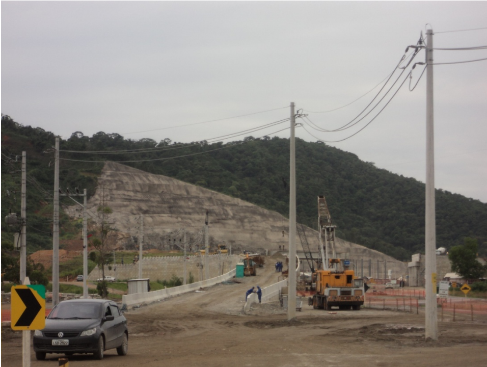
Figura 24 - Obra de construção do viaduto de acesso ao Porto
