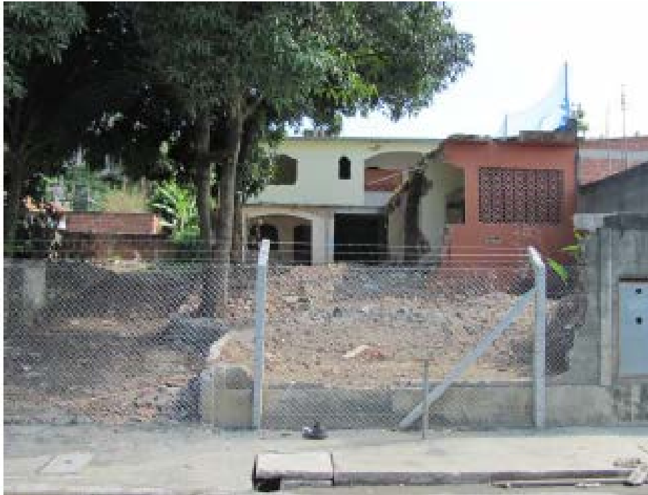
Figura 18 - Imóvel adquirido e parcialmente demolido
