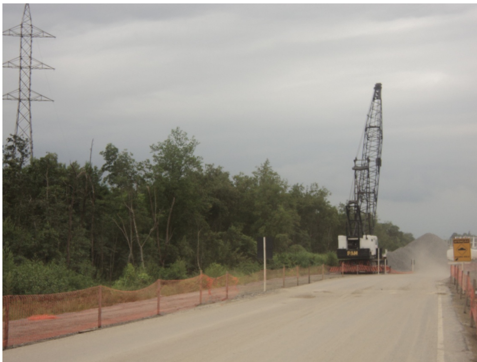
Figura 23 - Obra da linha férrea que traz o minério do Sistema Sudeste para o Porto Sudeste
