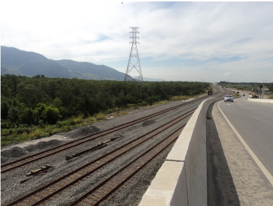
Figura 25 - Viaduto e linha ferroviária construídos para atender o Porto Sudeste
