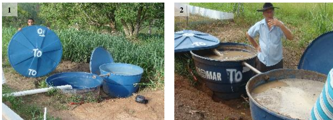
Figura 17 - Mosaico de fotografias. (1) instalação de segunda caixa coletora na Parcela T0; (2) caixas coletoras da Parcela T0 em operação, após evento de chuva. Fonte: o Autor, 2015.
