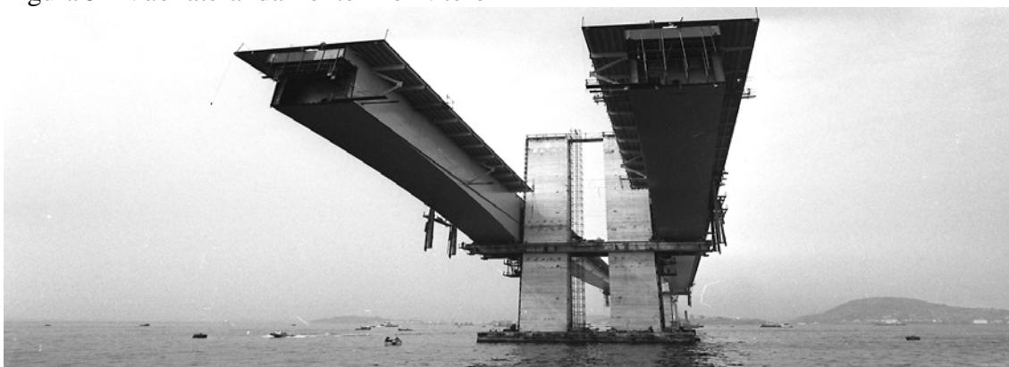
Figura 5 – Vão lateral da Ponte Rio-Niterói
