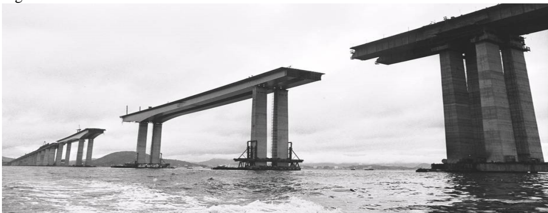
Figura 6 – Vão lateral da Ponte Rio-Niterói
