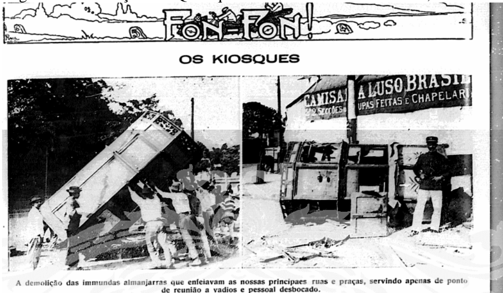
Figura 6 - Demolição dos Quiosques do centro do Rio de Janeiro, em 1911
