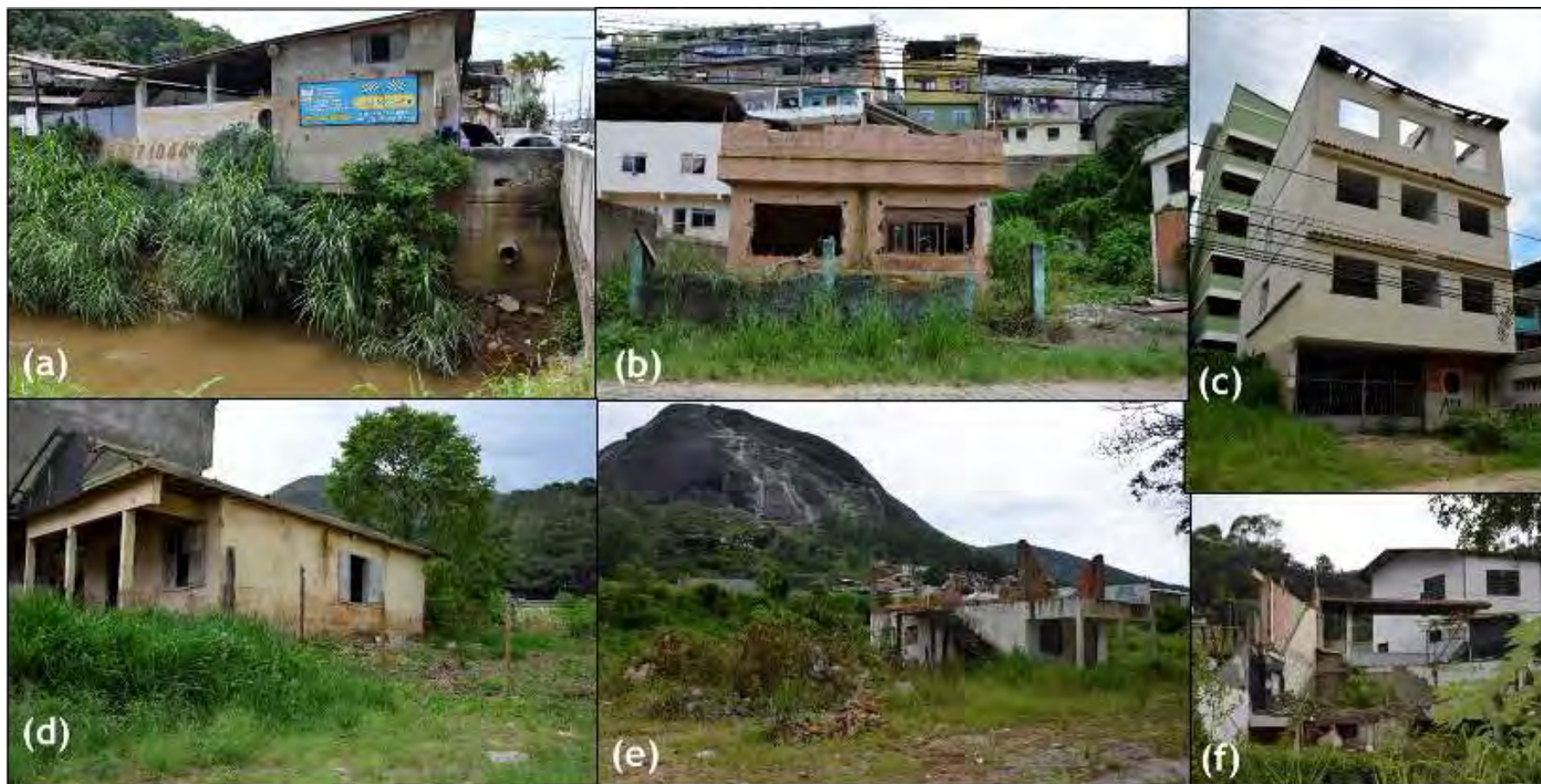
Figura 73 – Registro fotográfico da atual situação de ocupação na área delimitada pelo Inea como de desocupação compulsória.
