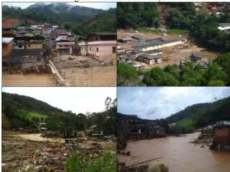
Figura 54 – Bairro do Córrego d’Antas inundado (uma das áreas mais atingidas no desastre de 2011).
