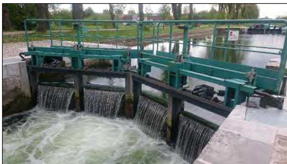
Figura 100 – Obras hidráulicas em um rio de Abbeville.
