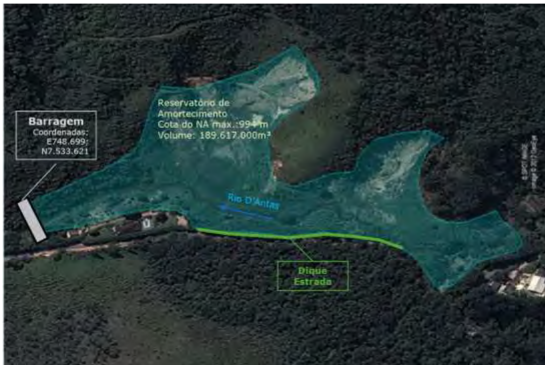
Figura 77 – Barragem de Cardinot e reservatório de amortecimento.
