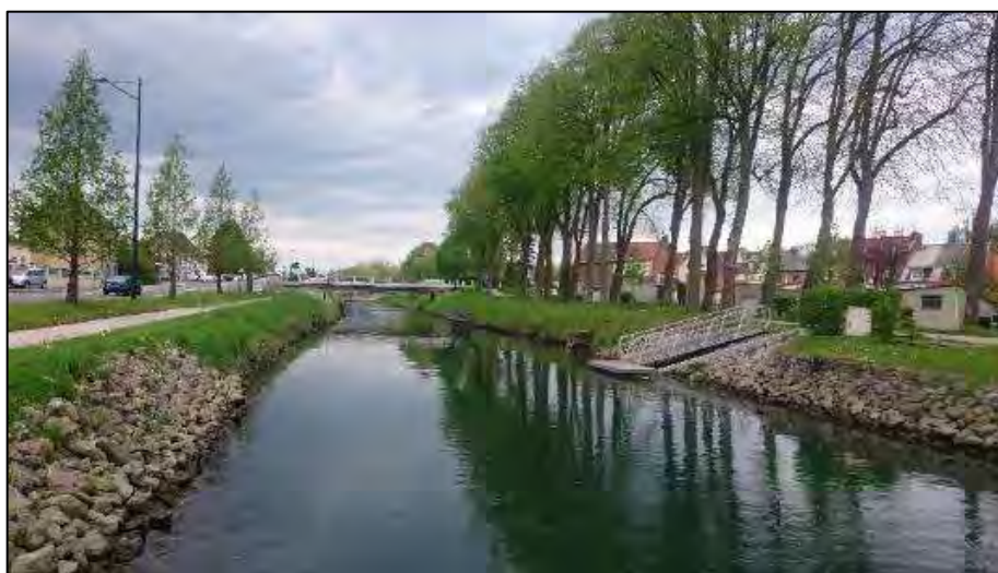
Figura 99 – Rio em Abbeville após obras de recuperação de suas margens.
