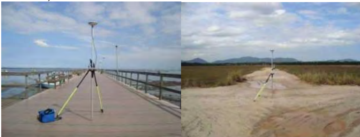
Figura 8 - Fotos de dois pontos de medição de coordenadas, com GNSS L1, para ortorretificação
