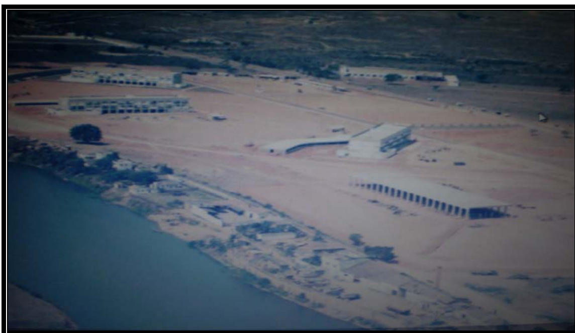
Fotografia 9 – Construção do Campus da UENF Fonte: Revista Nossa UENF – Especial de 15.08.2011.
