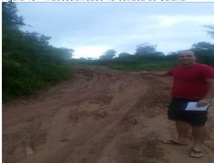
Figura 15 – Inacessibilidade na estrada de Caiana
