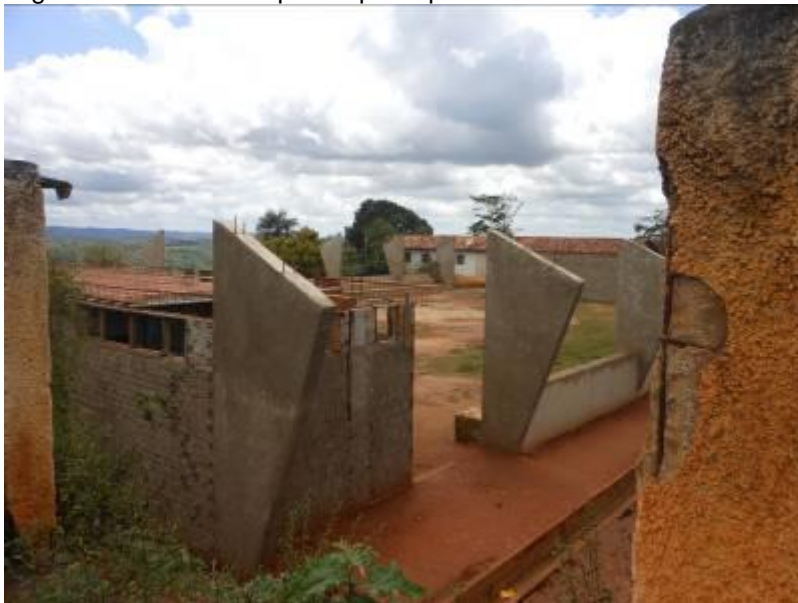
Figura 30 – Obras da quadra poliesportiva da Caiana
