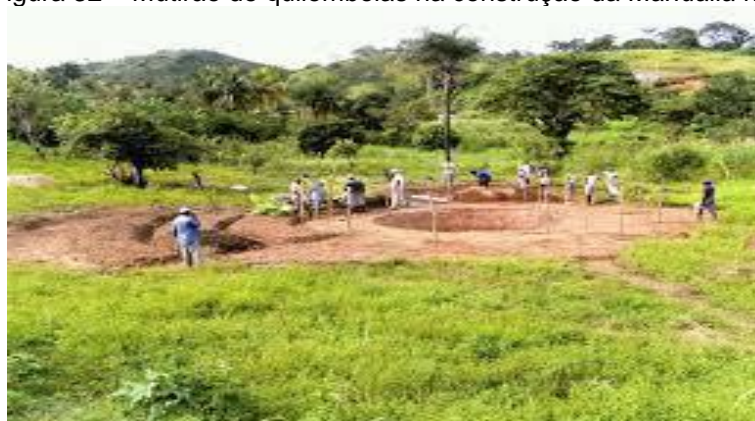
Figura 32 – Mutirão de quilombolas na construção da Mandalla na Caiana
