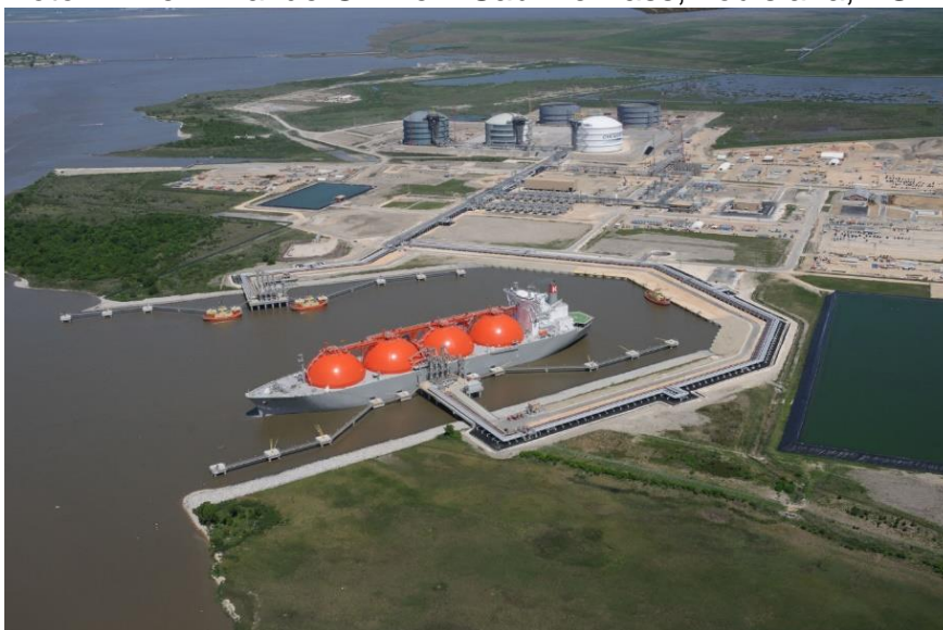
Foto 1 - Terminal de GNL em Sabine Pass, Louisiana, EUA.
