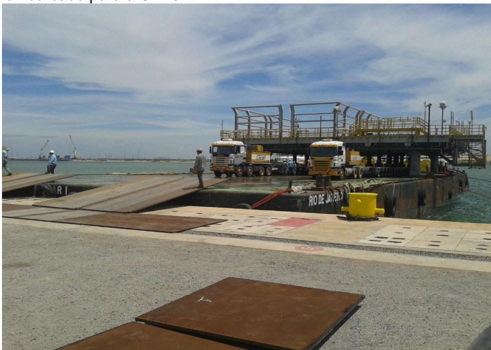
Foto 28 - Módulo montado pelo Consórcio Integra no Aço e embarcado para a China.
