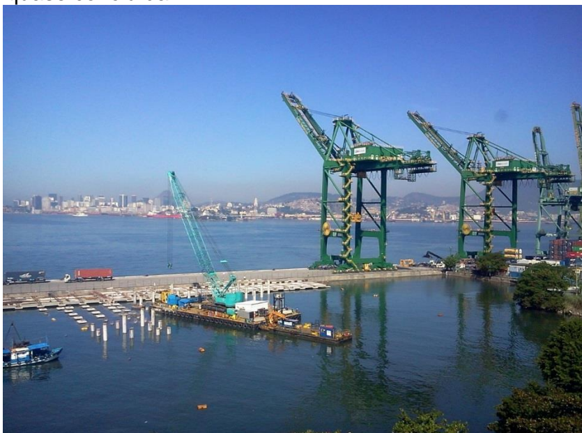
Foto 6 - Porto do Rio com ampliação do píer do terminal quase concluída
