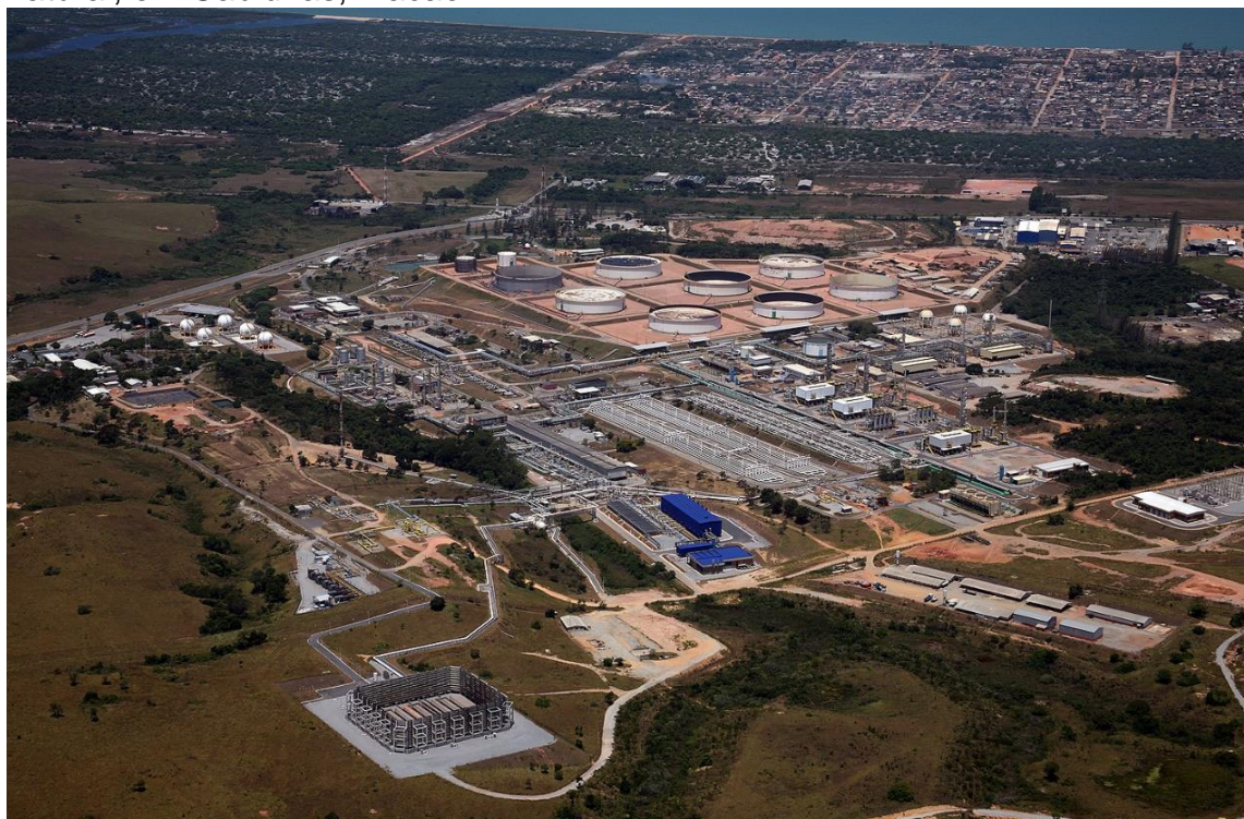
Foto 33 - Imagem aérea da UPGN no Terminal de Processamento de Gás Natural, em Cabiúnas, Macaé.
