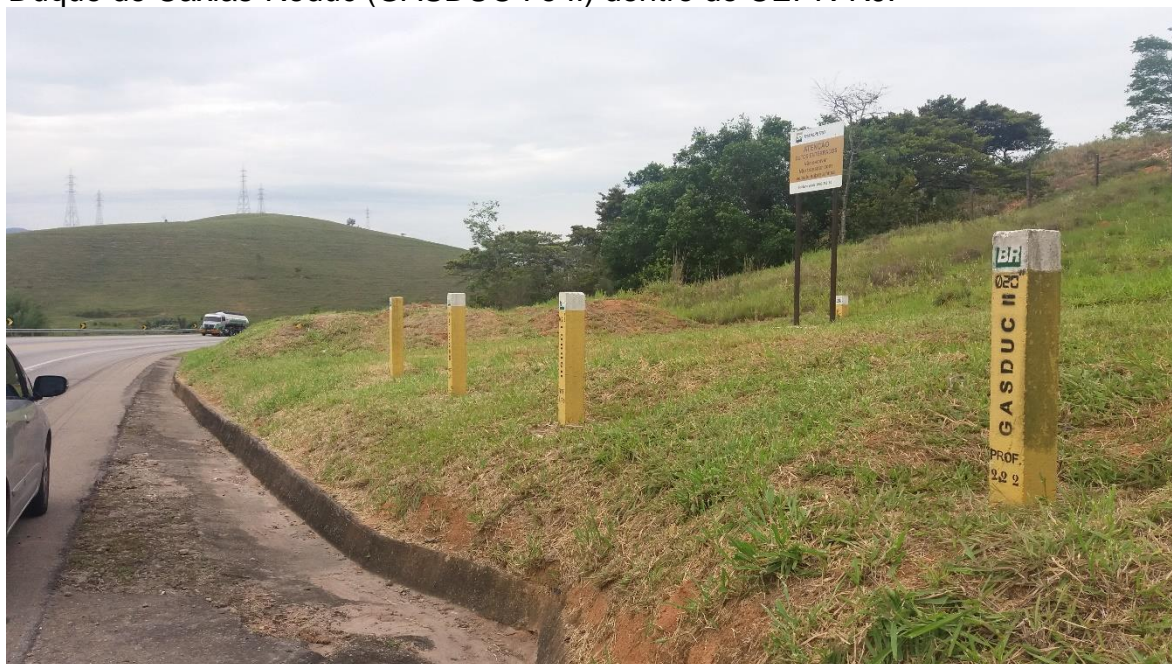
Foto 29 - Dois ramais de gasodutos e mais dois de oleodutos no trecho Macaé-Duque de Caxias-Reduc (GASDUC I e II) dentro do CEPR-RJ.
