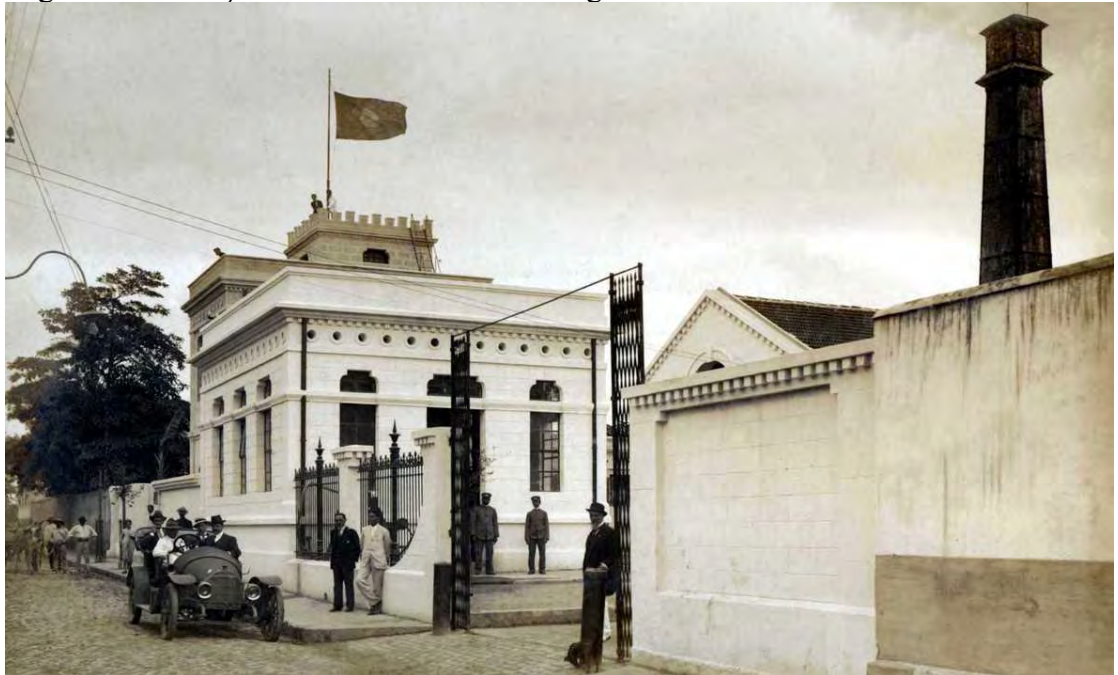
Figura 11 – Estação Elevatória Central de Esgoto.
