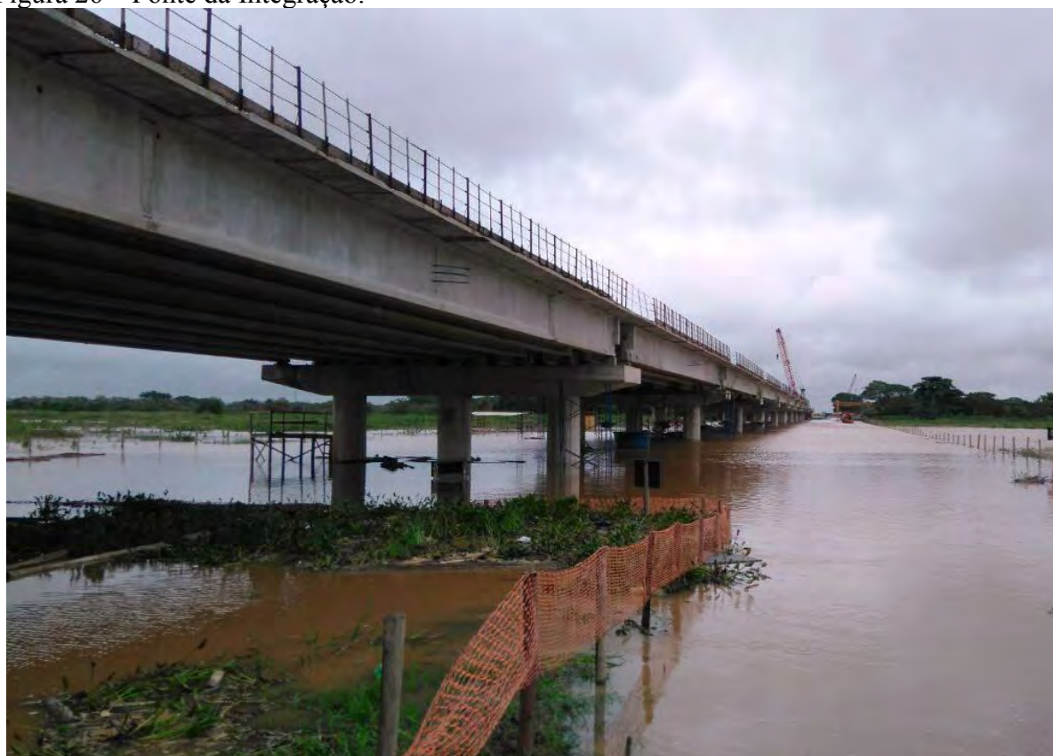
Figura 26 – Ponte da Integração.
