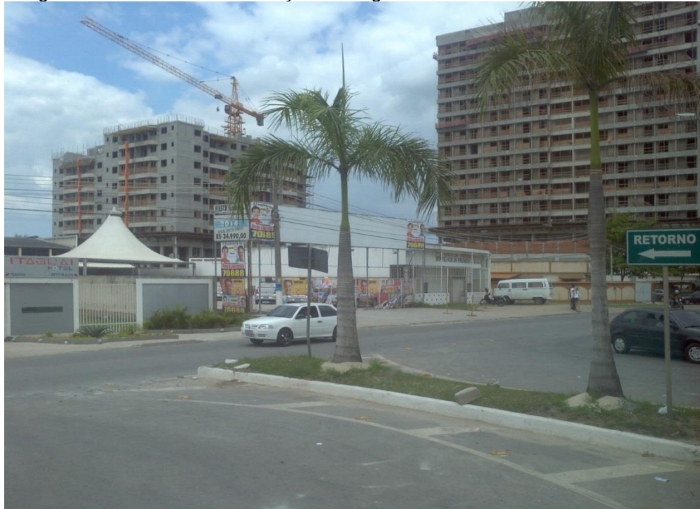
Imagem 15 – Prédios em construção em Itaguaí
