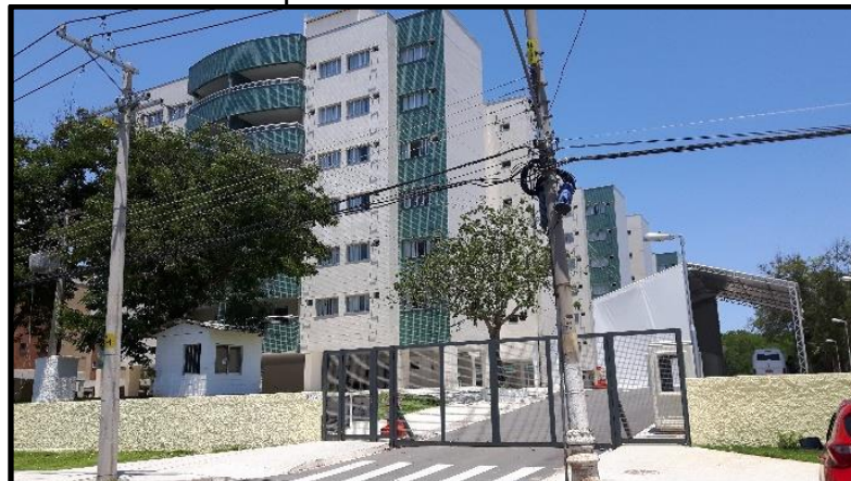
Figura 8 - Prédios Novos. Construção para jogos Olímpicos – 2016
