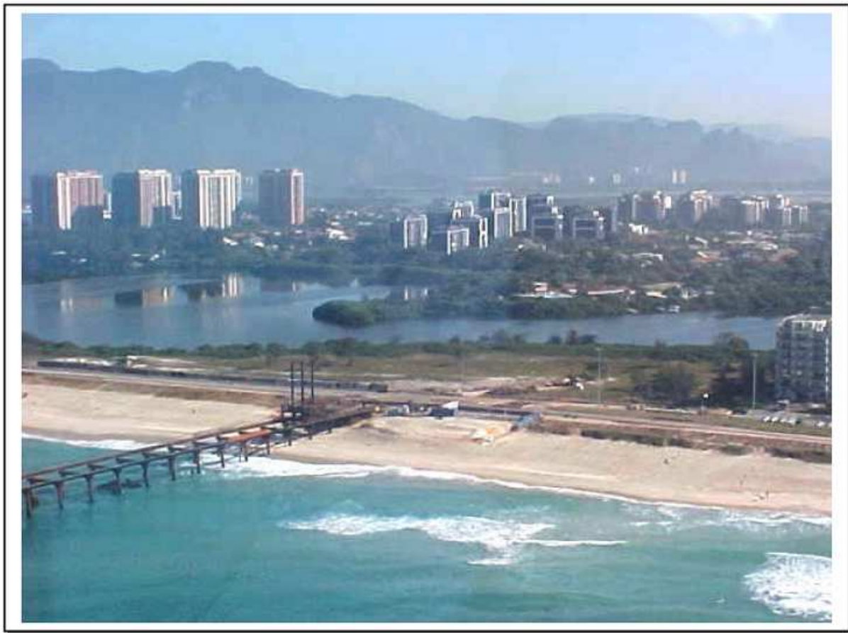
Figura 20 – Píer de assentamento do emissário submarino
