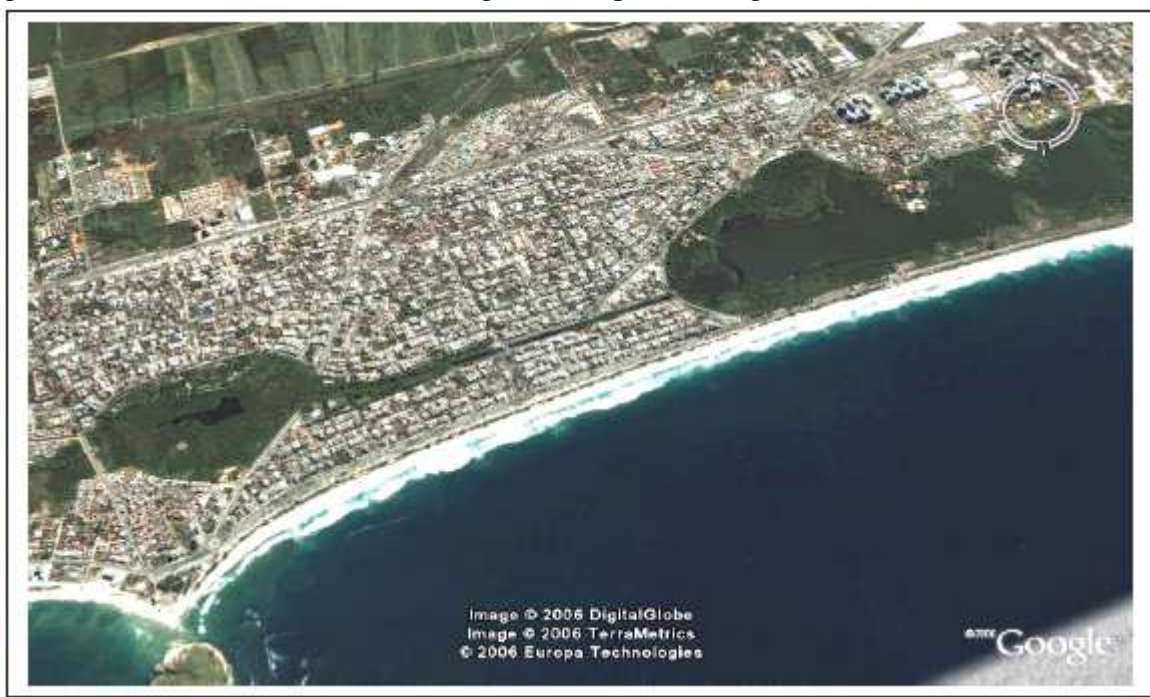
Figura 12 – Canal das Taxas entre as lagoas Marapendi e Lagoinha
