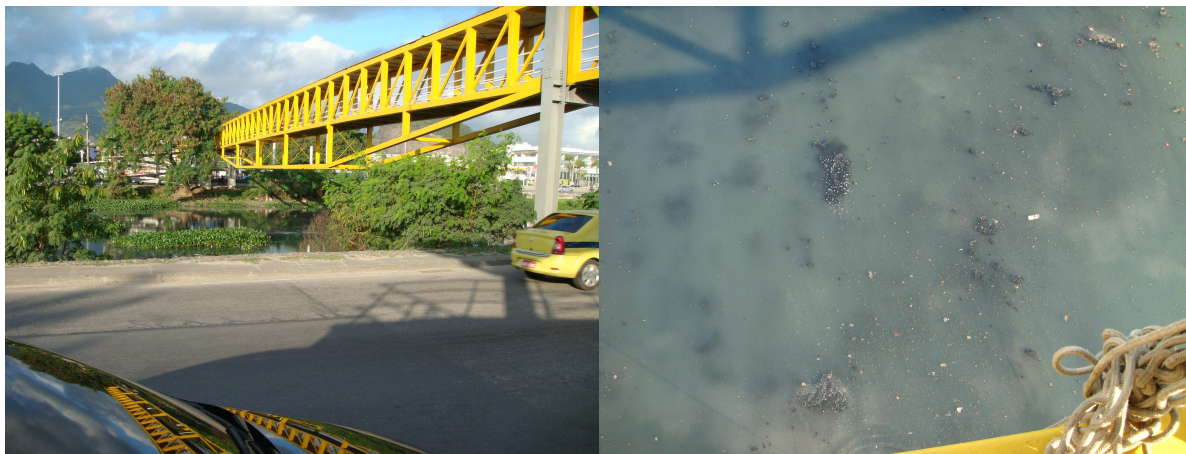
Figura 33 – Coleta de amostra do Arroio Fundo, depois da UTR instalada
