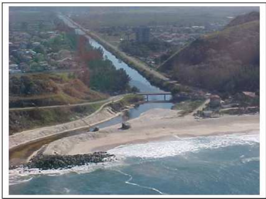
Figura 16 – Desembocadura do canal do Sernambetiba na praia da Macumba
