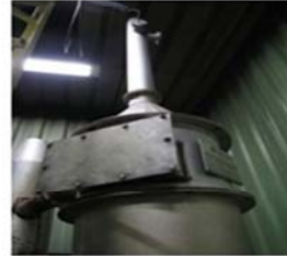
Incinerador de lixo
