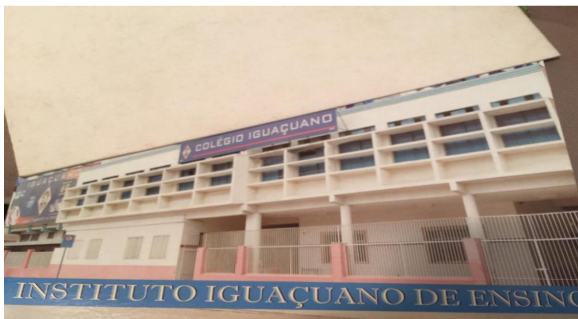
Figura 55 - Fachada atual do Colégio Iguaçuano
