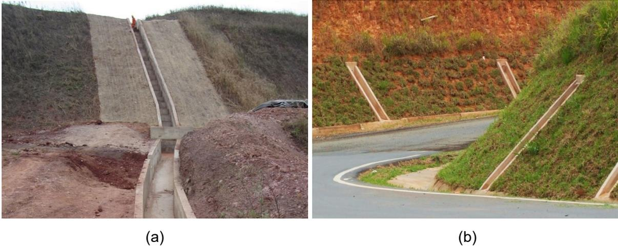
Figura 19 – (a) Sistema de drenagem superficial com canaleta e caixa coletora (Deflor Bioengenharia, 2006); (b) Sistema de drenagem profunda associada a canaleta (Deflor Bioengenharia, 2019)
