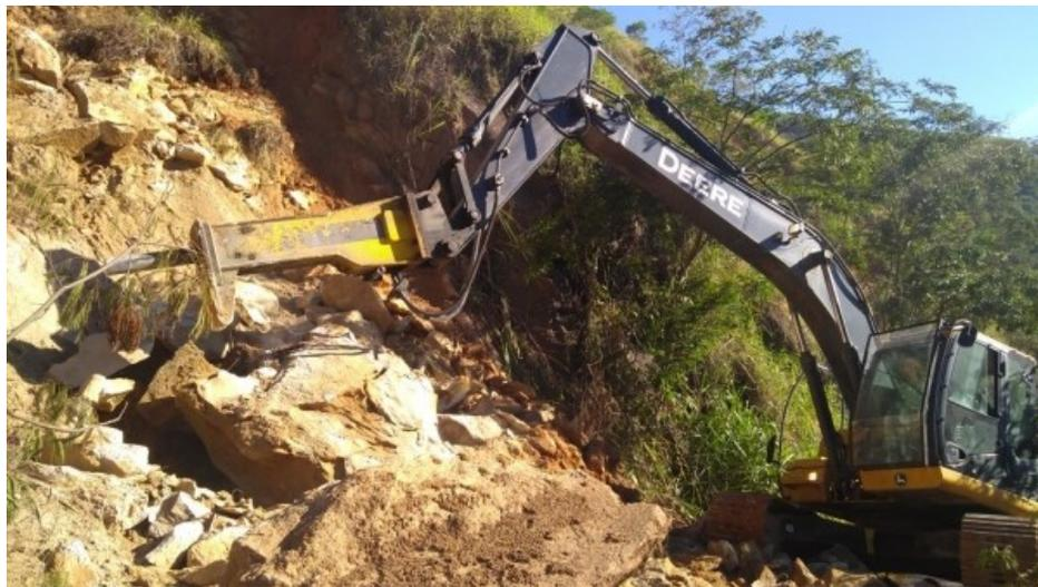
Figura 18 - Desmonte de blocos rochosos com rompedor hidráulico (Prefeitura de Petrópolis, 2018)
