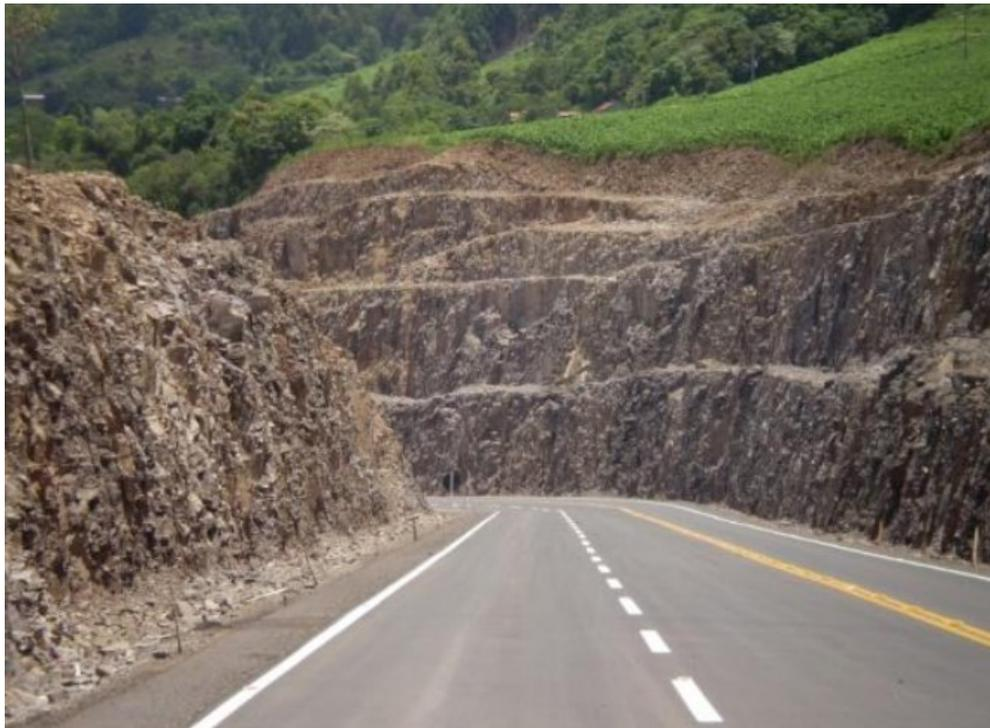
Figura 14 - Bermas em encosta rochosa (Adaptado de Galvéz, 2012)
