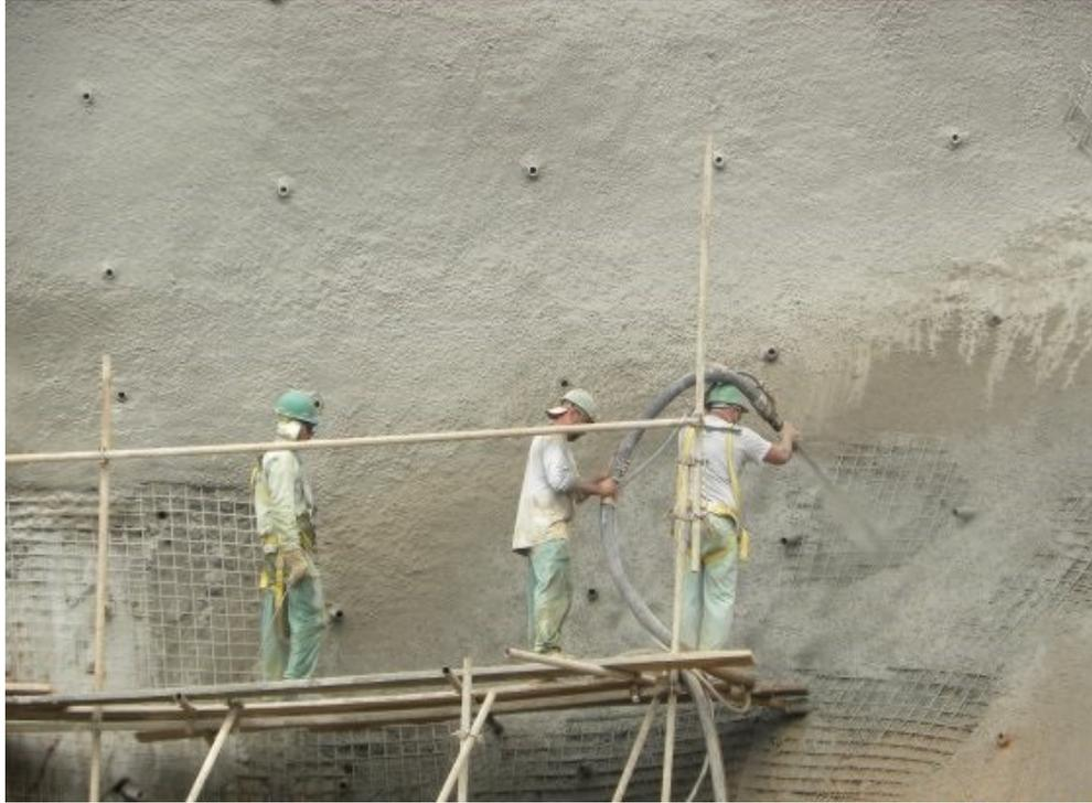
Figura 20 - Proteção superficial em encosta com uso de concreto projetado (Solotrat, 2010)
