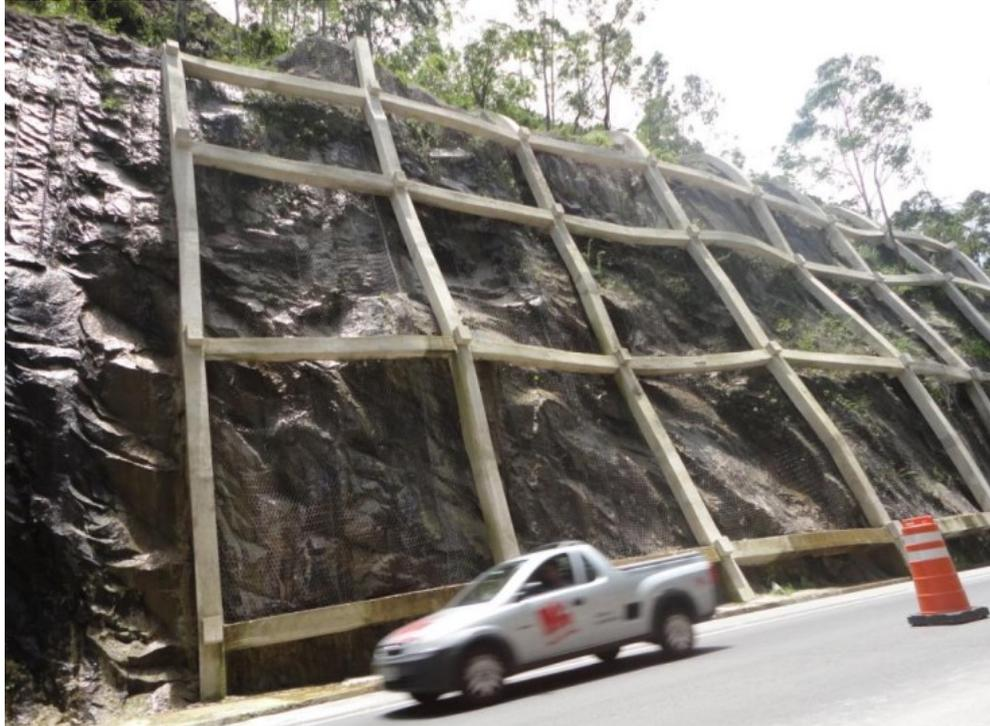
Figura 22 - Grelhas ancoradas em talude rochoso (Freitas, 2013)
