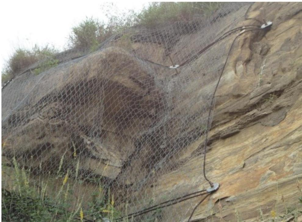
Figura 12 - Tela metálica para controle de queda de blocos (Adaptado de Freitas, 2013)
