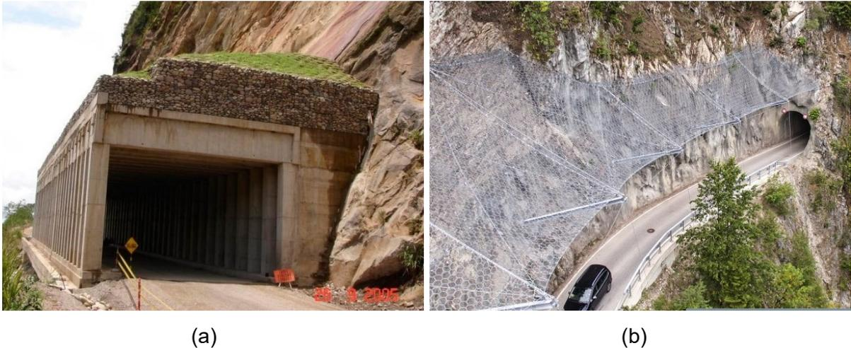
Figura 16 - (a) Túnel falso de concreto (Diaz, 2005); (b) Túnel falso flexível (Geobruigg, 2018)
