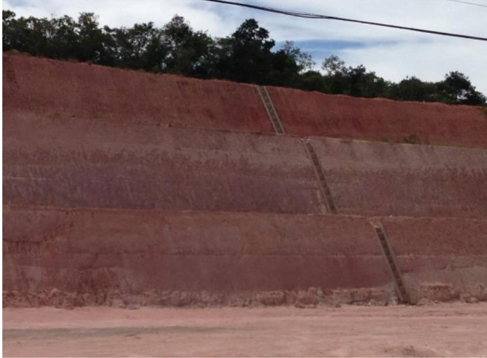
Figura 21 - Retaludamento em banquetas (Nascimento, 2015)
