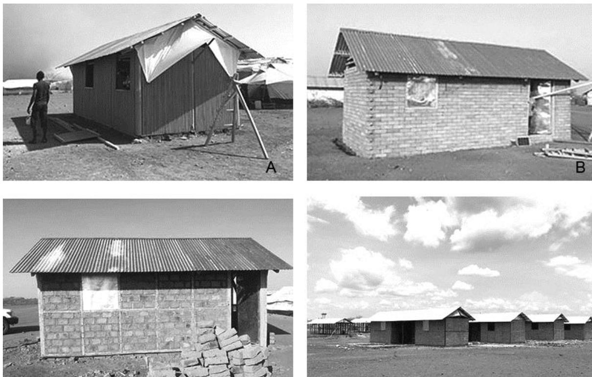
Protótipos em estrutura de tubos de papel (A), de alvenaria (B) e de estruturara leve de madeira com fechamento em alvenaria (C). Unidades implantadas do terceiro sistema (D).
