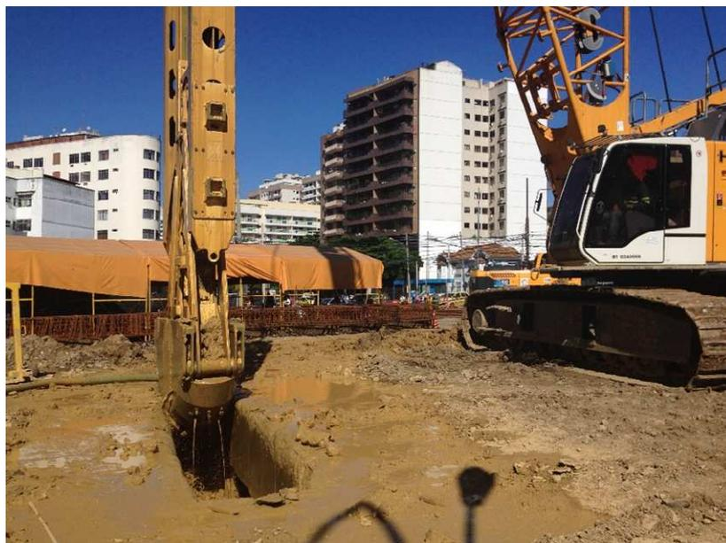
Figura 26 - Etapa de escavação das paredes-diafragma com equipamento *Clam-Shell*.
