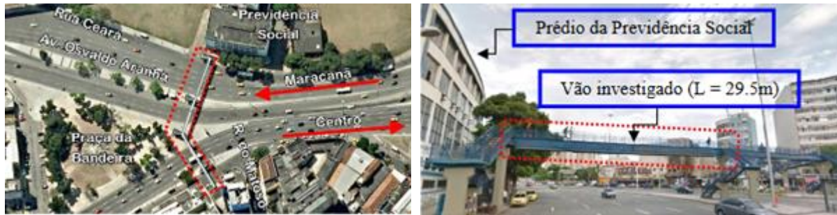
a) Vista superior da passarela
