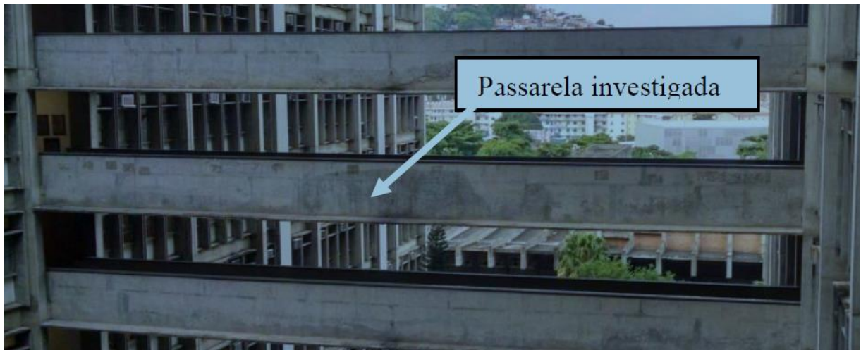
Figura 14 – Passarela que conecta os edifícios da UERJ, DEBONA e SILVA (2019)
