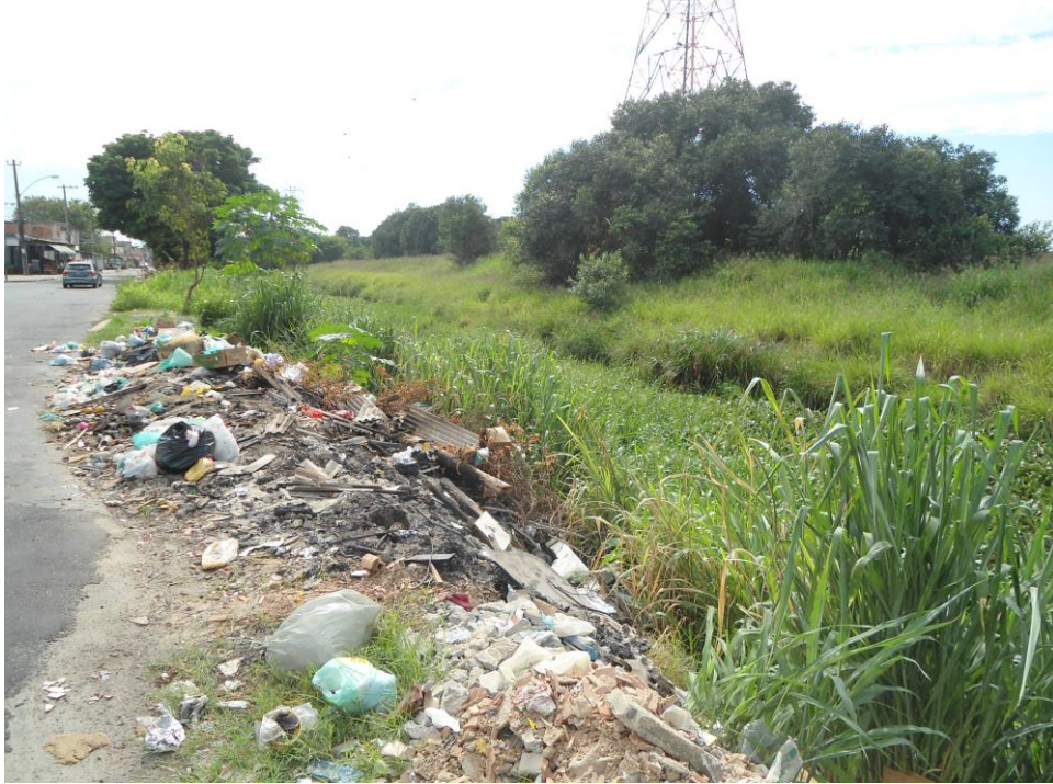
Figura 22 - Resíduo de construção civil na borda do Canal São Fernando
