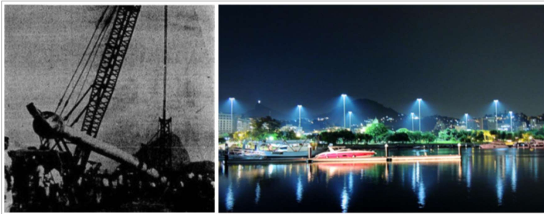
Figura 32 – Instalação do posteamento (à esquerda) e vista do posteamento do Parque do Flamengo (à direita)
