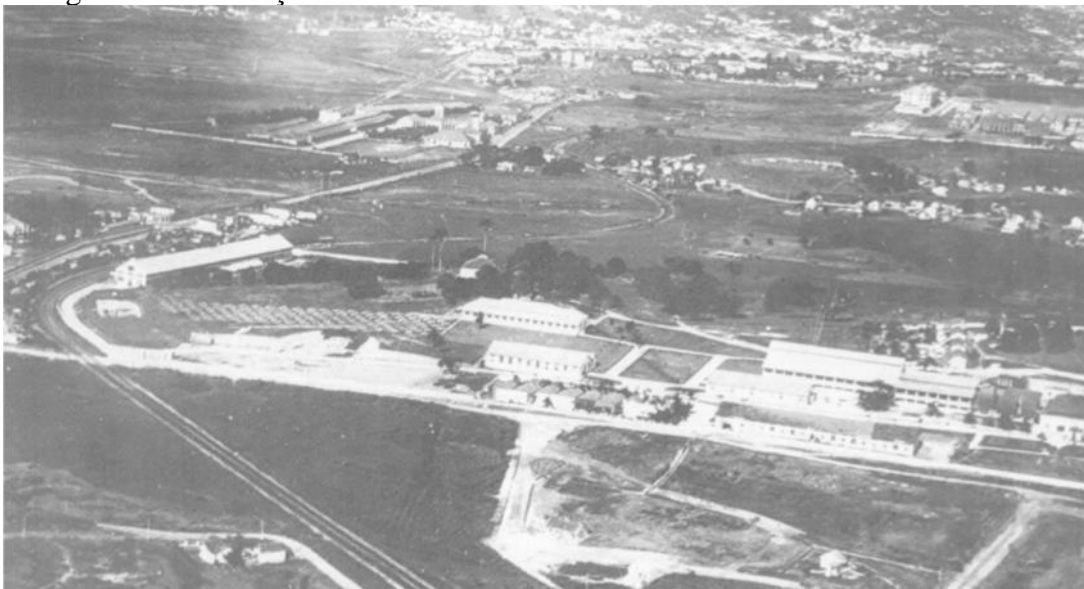
Imagem 13 - Instalações da Fábrica da GE na década de 1920.
