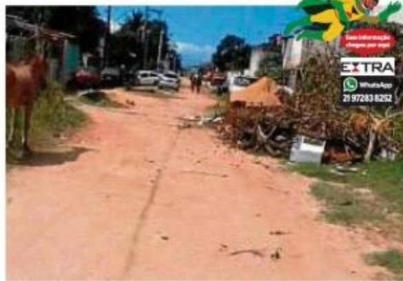
Rua Impala com muito lixo e sem pavimentação: abandono
