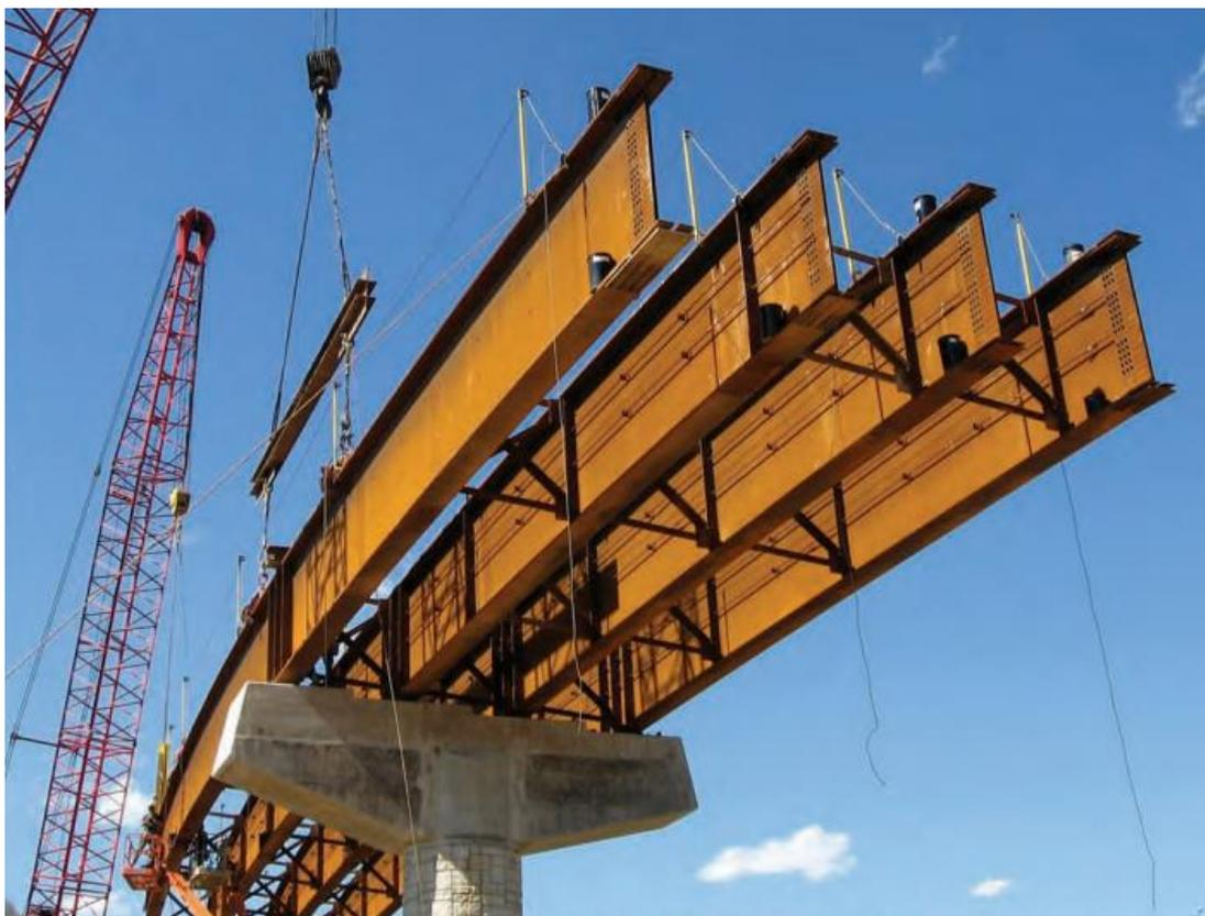
Figura 3 - Montagem da estrutura metálica de ponte mista (AASHTO, 2011)
