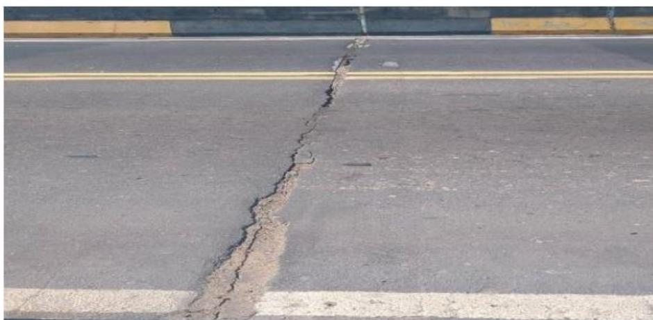
Figura 8 - Juntas de dilatação com desgaste na ponte Senador Fábio de Lucena: Manaus, AM (SILVA; SOUZA, 2018)
