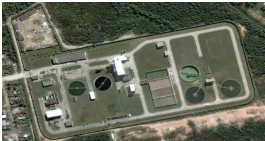
Figura 29 – Vista aérea da ETE Sarapuí, Rio de Janeiro-RJ.
