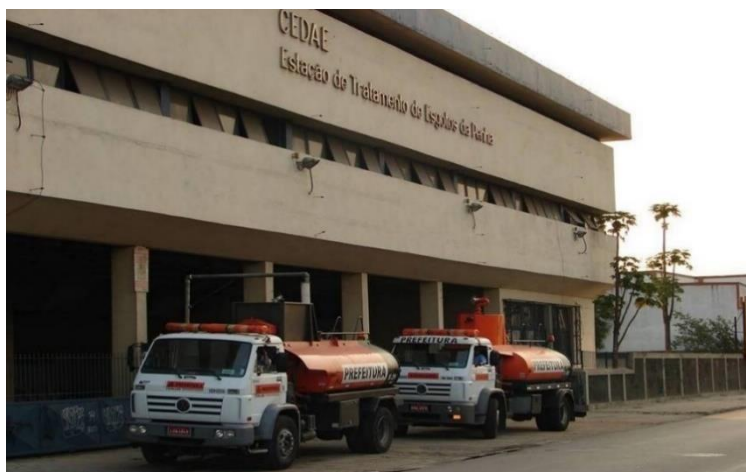
Figura 19 – Tomada d'água de caminhão pipa de água de reúso na ETE Penha.
