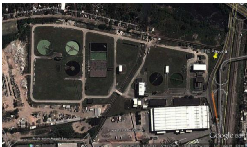
Figura 28 – Vista aérea da ETE Pavuna, Rio de Janeiro-RJ
