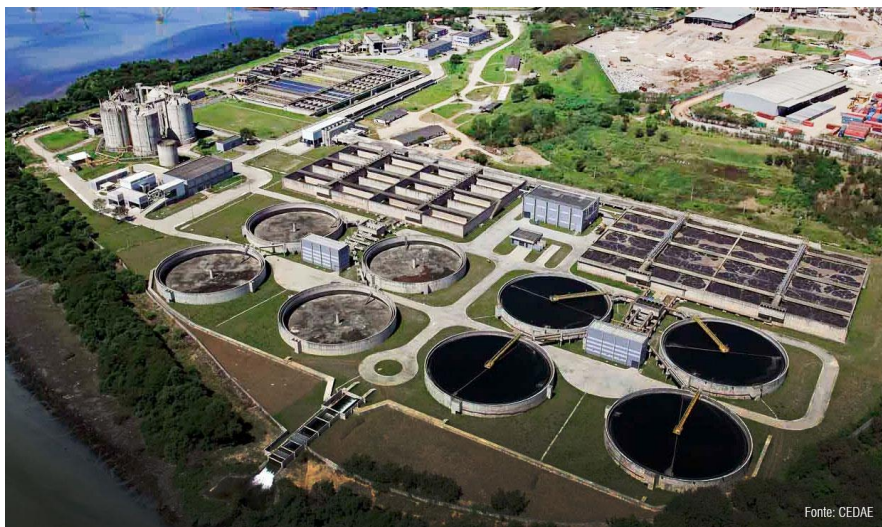
Figura 26 – Vista aérea da ETE Alegria, Rio de Janeiro-RJ.
