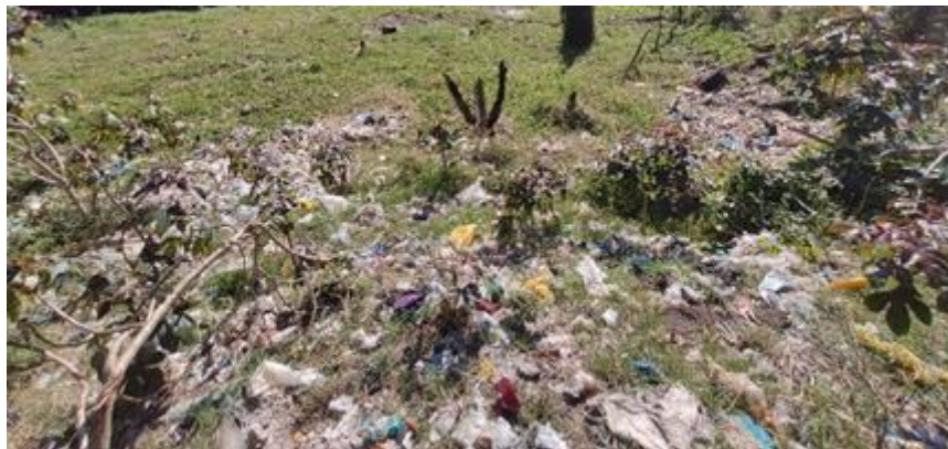
Figura 18 - Afloramento de resíduos no topo do maciço 2
