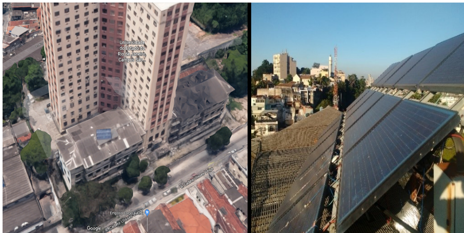
Figura 10: - Localização e vista do conjunto fotovoltaico da UERJ.
