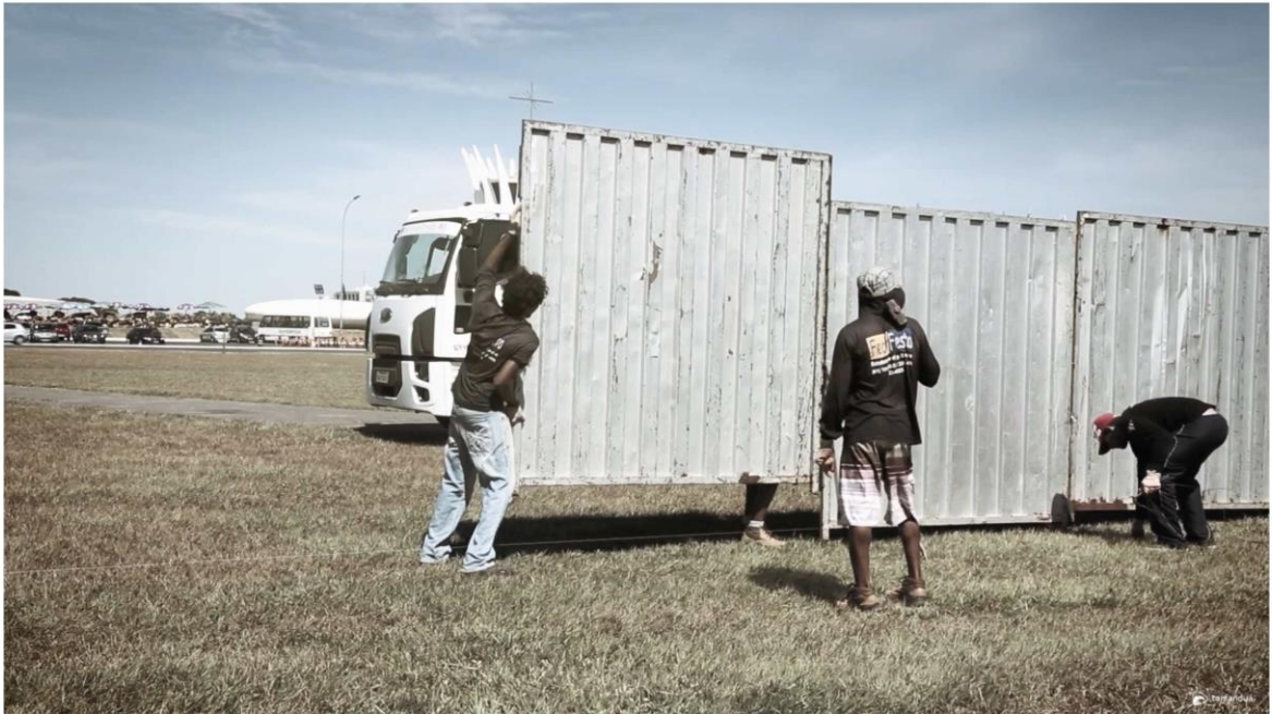
Figura 21 - O muro ideológico sendo instalado
