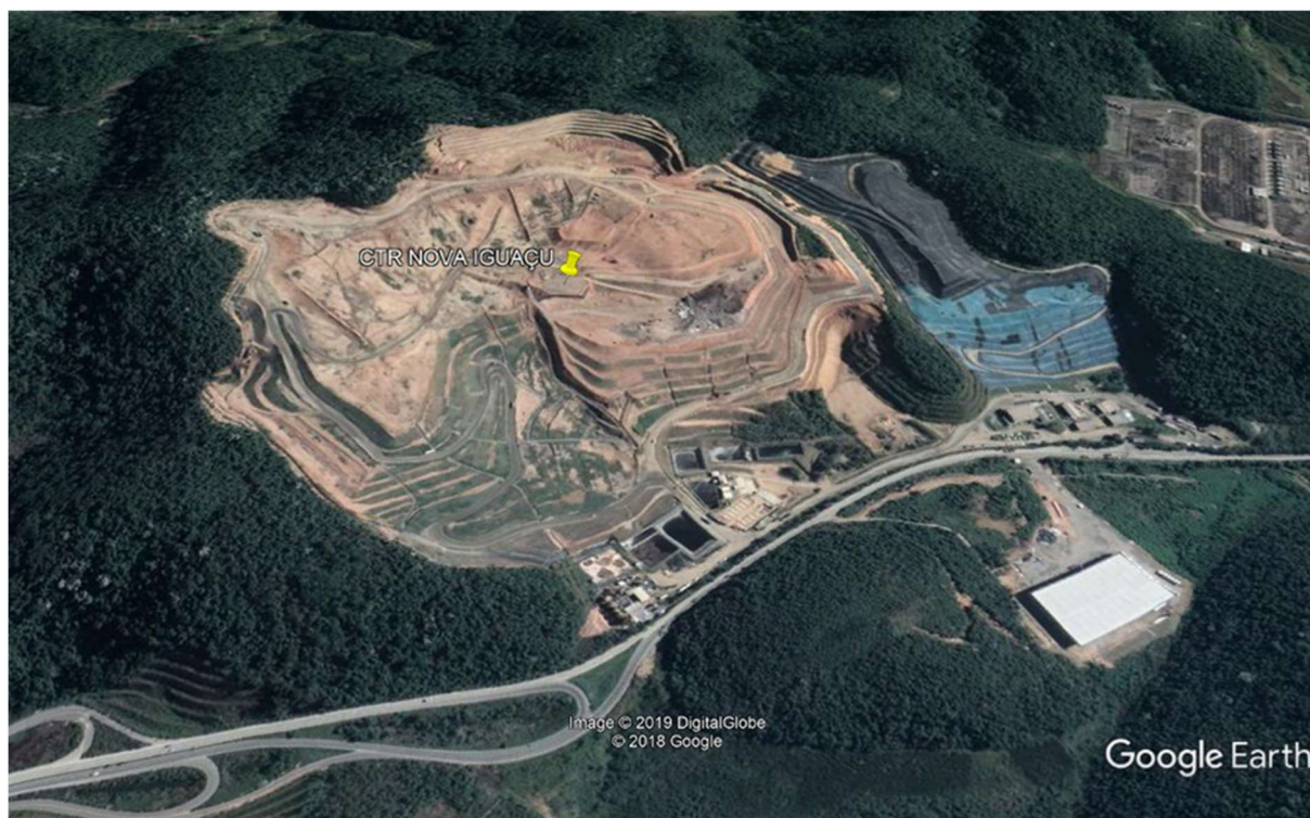
Figura 21: Imagem aérea do CTR Nova Iguaçu Fonte: Software Google Earth (2019)
