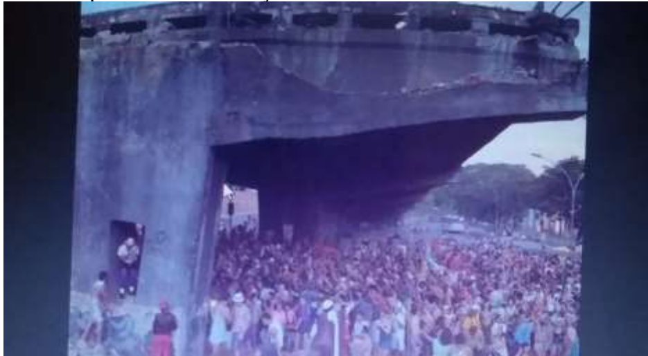
Figura 36 - Bloco “Vamo ET” realiza “O último Baile da Perimetral”, durante o processo de demolição.
