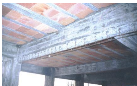
a) adição de barra de aço
