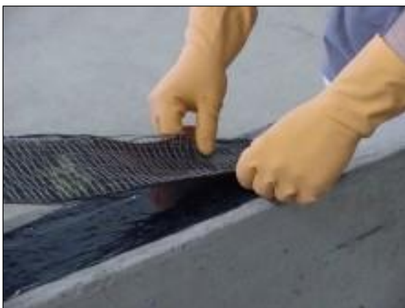
Figura 30 – Posicionamento da manta flexível
