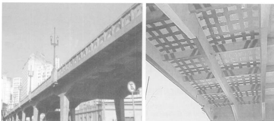
Figura 23 - Reforço do viaduto Santa Teresa
