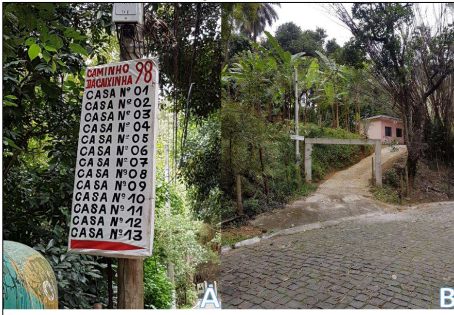
Figura 76 - Casas inseridas no PNMSM/PEM e moradia construída irregularmente, localizada dentro dos limites do PEM/PNMSM em Bangu
