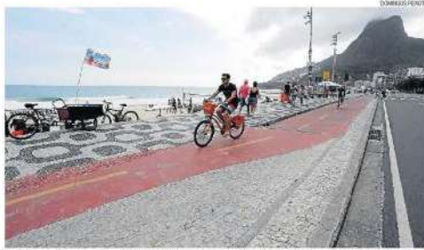
Risco de acidentes. Governo do estado não dá sequer uma previsão de solução para o estreitamento da pista
