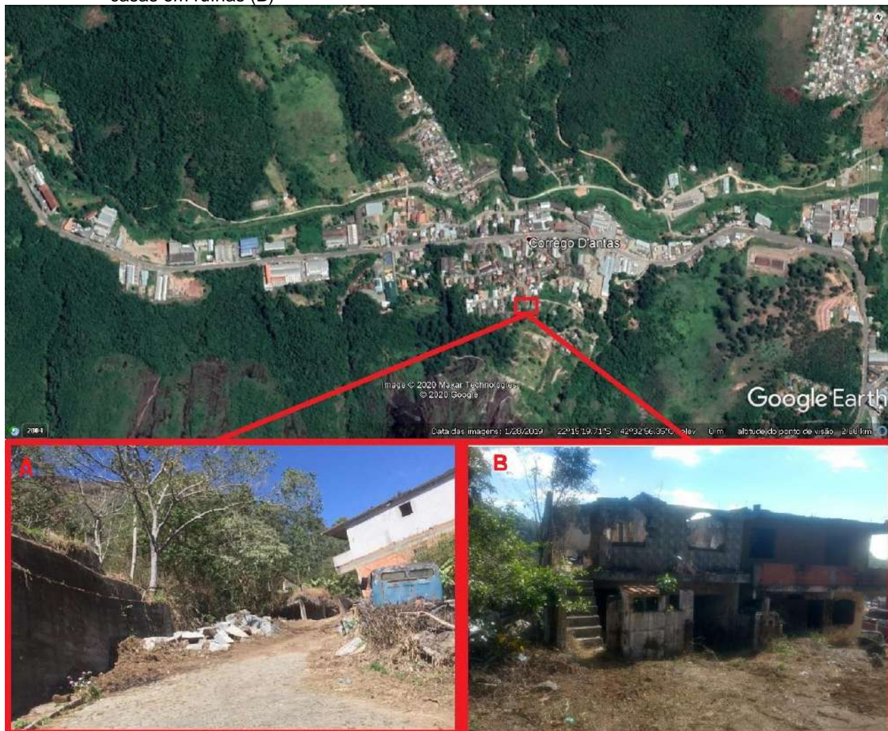
Figura 28 - Aspecto atual de trecho da parte alta do bairro: pedaços de rochas remanescentes (A) e casas em ruínas (B)
