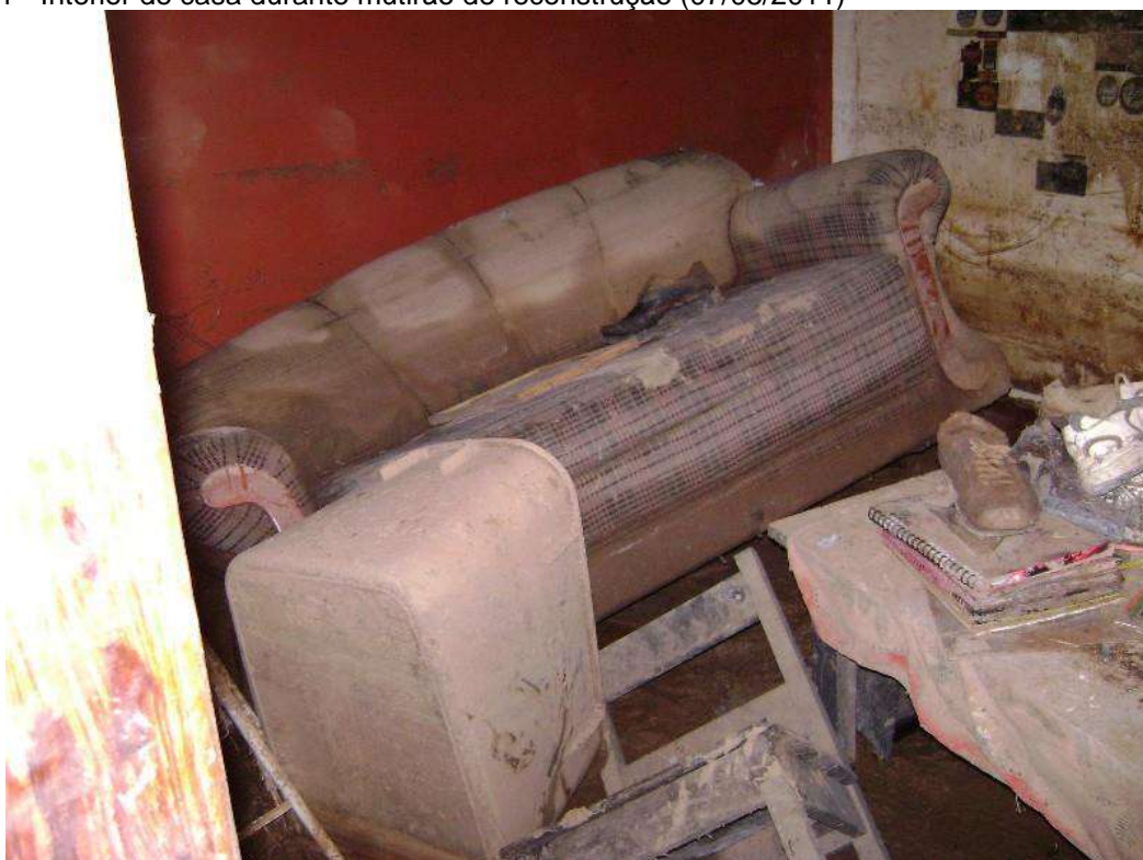
Foto 11 - Interior de casa durante mutirão de reconstrução (07/05/2011)
