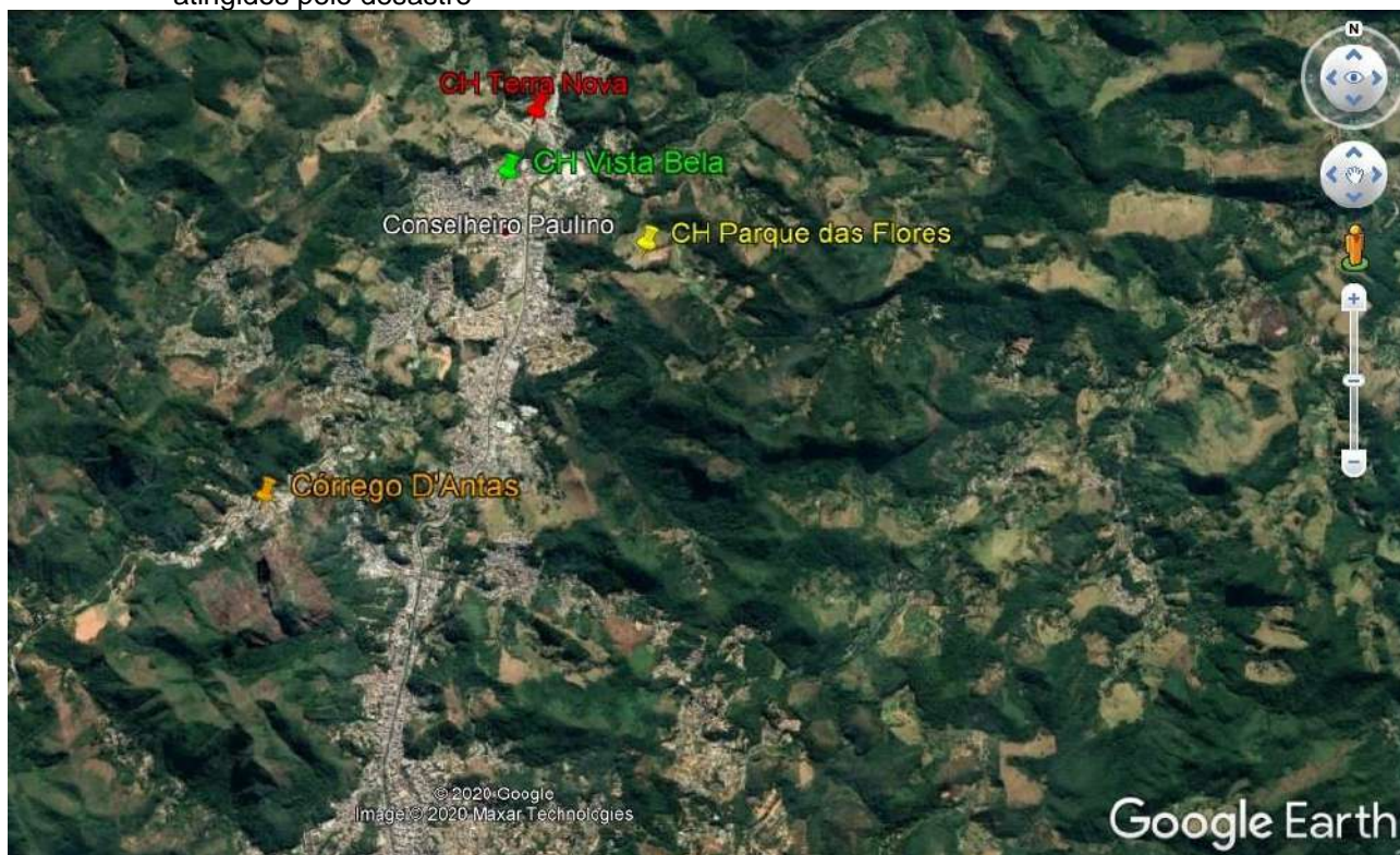
Figura 29 - Localização dos conjuntos habitacionais construídos pelo poder público para abrigar os atingidos pelo desastre
