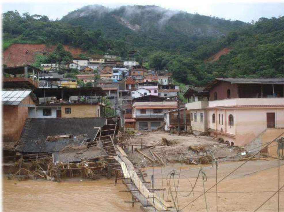
Foto 5 - Cenário pós-tragédia no Córrego D'Antas (ponte improvisada pelos moradores)
