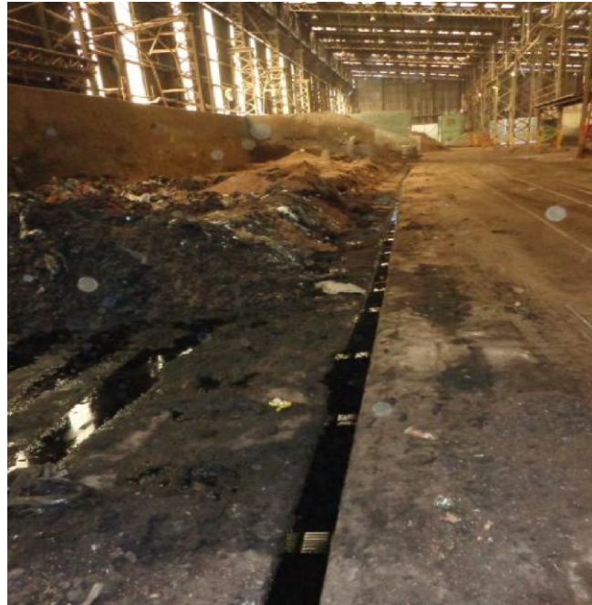
Figura 23: Captação de efluentes das baias de mistura e descanso
