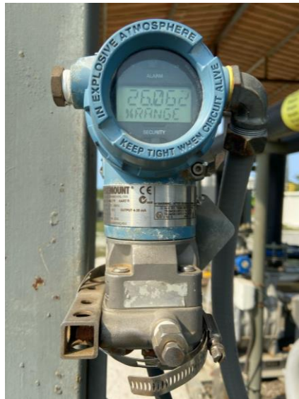
Figura 34 – Transmissor de Pressão
