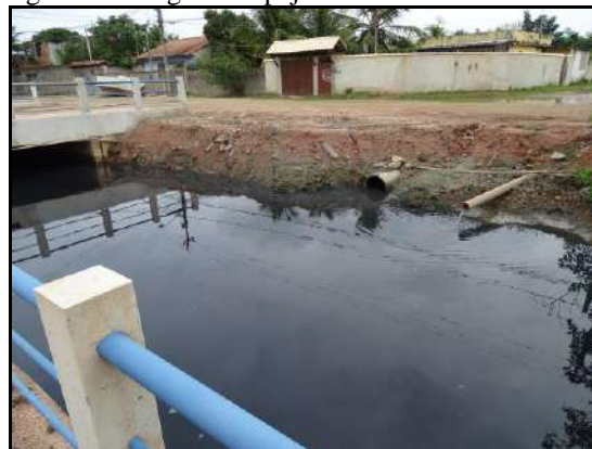
Figura 27 - Esgoto despejado em canal em canal
