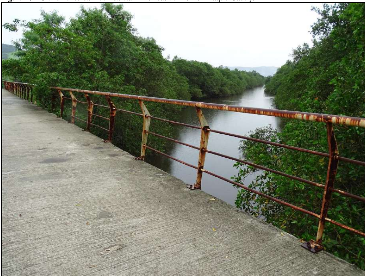
Figura 23 - Cruzamento da Avenida das Américas com o rio Piraquê-Cabuçu
