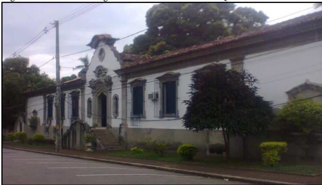
Figura 44- Exterior do antigo edifício da Escola Mixta da Quinta da Boa Vista
