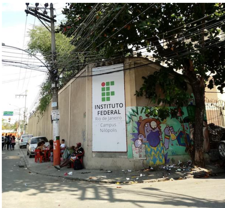
Figura 14 – Fachada do campus do IFRJ em Nilópolis.
