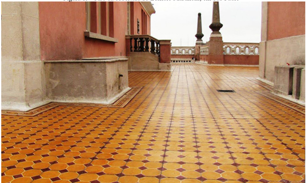
Figura 19 - Piso da cobertura do Edifício Martinelli, em São Paulo
