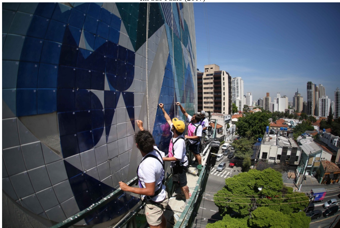
Figura 59 - Integrantes do Coletivo MUDA instalando o painel na fachada de um edifício no bairro de Pinheiros em São Paulo (2017)
